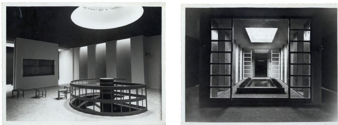
Fig. 16: Vista di quello che doveva essere l'originale ingresso al museo (sinistra) e della gipsoteca (destra) a progetto appena concluso ( https://phaidra.cab.unipd.it/o:355926 e https://phaidra.cab.unipd.it/o:355924 )
