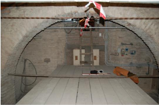
Fig. 2.24. Nella ripresa fotografica effettuata il 26 gennaio 2015 nell'ambiente soprastante il presbiterio, si può vedere la catena segnalata da Selvatico nel 1870.
