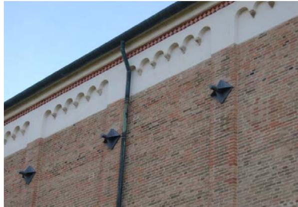
Fig. 2.74. La fotografia, realizzata il 20 novembre 2014, mostra il posizionamento degli ancoraggi disposti centralmente rispetto il punto medio delle lesene.
