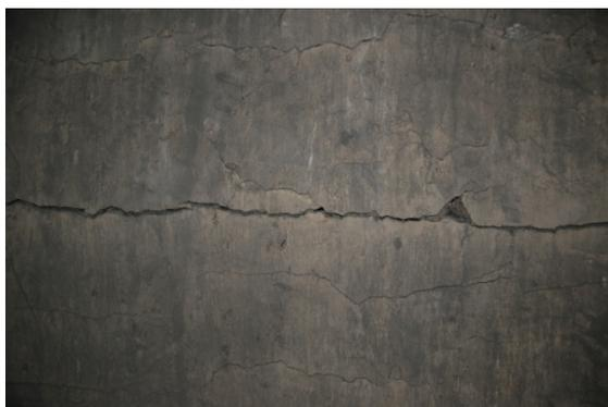
Fig. 2.82. Fessurazione ristilata sulla volta botte. Ripresa fotografica eseguita il 20 novembre 2014.
