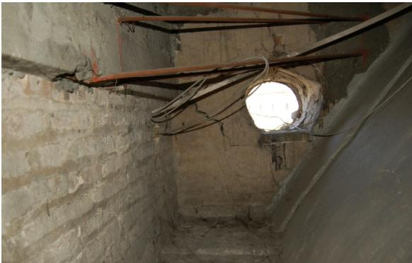
Fig. 2.79. Fessurazione diagonale nella controfacciata, visibile dal sottotetto, fotografia effettuata il 26 gennaio 2015.
