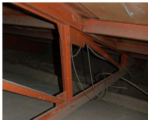
Fig. 2.68. La fotografia, realizzata il 15 ottobre 2014, mostra lo stato attuale delle capriate, le piastre saldate che collegano tra loro le aste. Si possono notare anche le terzere
