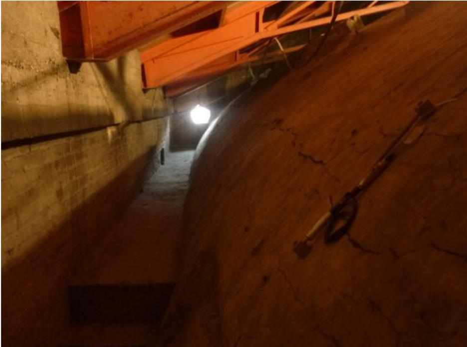
Fig. 5.18. Disposizione dei potenziometri sulle lesioni longitudinali site all'estradosso della volta.
