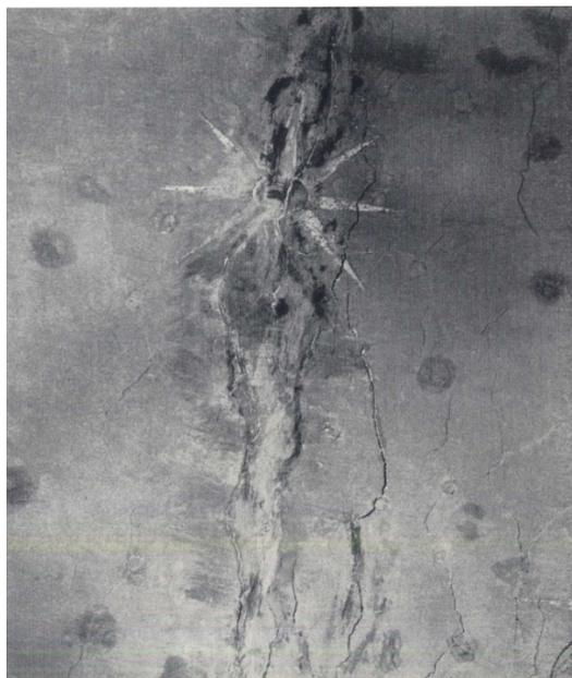
Fig. 2.30. Le lesioni all'intradosso della chiave della volta aumentate di numero e grandezza nel 1960 rispetto a quelle rilevate nel 1871; FABBRI COLABICH, PROSDOCIMI, SACCOMANI, *I recenti lavori*, cit., Fig. 3.
