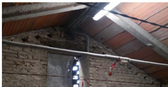
Fig. 2.27. Nella ripresa fotografica, eseguita il 24 ottobre 2014, si può notare come, ancora oggi, siano visibili i fori rimasti nel muro dovuti alla presenza un tempo delle travi del solaio ligneo.
