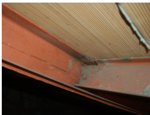
Fig. 2.70. La fotografia, realizzata il 15 ottobre 2014, mostra il collegamento tramite bulloni tra le terzere e i puntoni. Il manto di copertura in tavelloni è posto al di sopra delle terzere.
