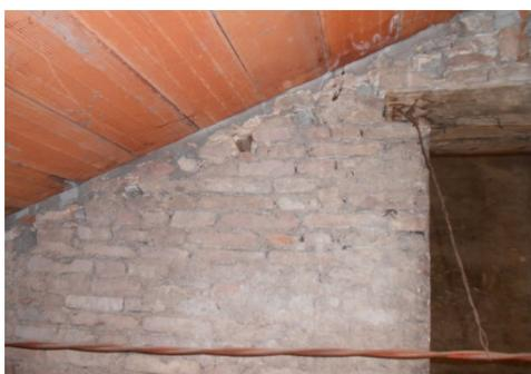
Fig. 2.26. Nella ripresa fotografica, eseguita il 24 ottobre 2014, si può notare come, ancora oggi, siano visibili i fori rimasti nel muro dovuti alla presenza un tempo delle travi del solaio ligneo.
