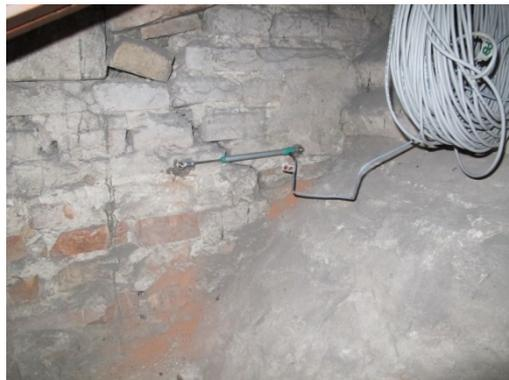
Fig. 2.80. Fessurazione diagonale nell'arcone, visibile dal sottotetto, fotografia effettuata il 26 gennaio 2015.
