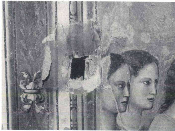
Fig. 2.38. In riferimento alla Fig. 3.15 si può vedere il foro in cui era collocata la catena trecentesca posta al limite del riquadro stesso, attorno al foro è visibile l'intonaco; FABBRI COLABICH, PROSDOCIMI, SACCOMANI, *I recenti lavori*, cit., Fig. 11.
