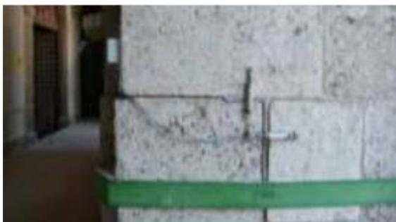
Fig. 4.3. Forte Spagnolo all'Aquila: i sensori di spostamento sono posizionati al piede dei pilastri verso il cortile per controllare il fenomeno di ribaltamento del fronte interno, oltre a sonde di rilevazione dei parametri ambientali.
