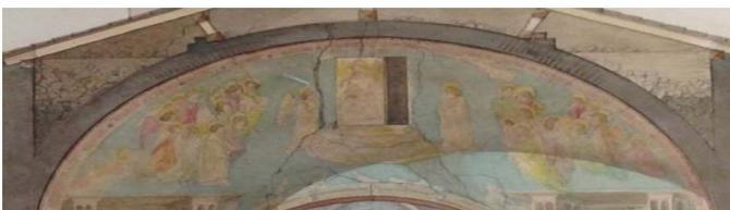
Fig. 2.85. Fessurazione ristilata sull'arcone, ripresa fotografica eseguita il 20 novembre 2014.
