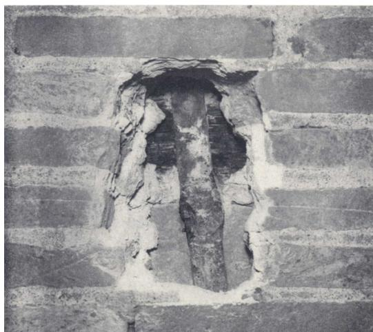
Fig. 2.40. L'ancoraggio del paletto di una delle catene trecentesche costituito superiormente da una trave di legno e inferiormente da un blocco di trachite visibili dal foro praticato all'esterno della parete; FABBRI COLABICH, PROSDOCIMI, SACCOMANI, *I recenti lavori*, cit., Fig. 13.
