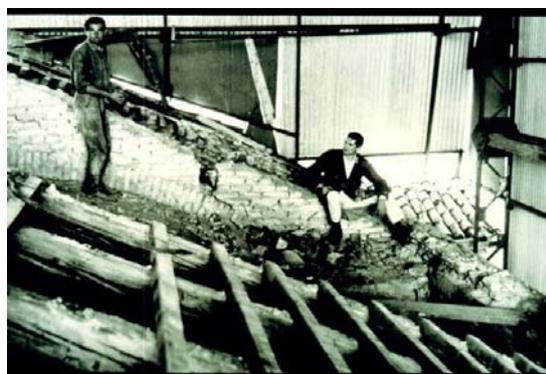
Fig. 2.33. Rimozione della copertura in legno, trattino fotografia nel corso dei lavori 1961-63; MODENA, *Aspetti costruttivi e strutturali*, cit., p. 115, Fig. 15.
