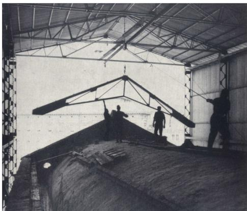
Fig. 2.34. Il sollevamento di una nuova capriata metallica con il paranco scorrente sulla guida sostenuta dalle incavallature della tettoia provvisoria; **FABBRI COLABICH, PROSDOCIMI, SACCOMANI, I recenti lavori, cit., Fig. 23.**
