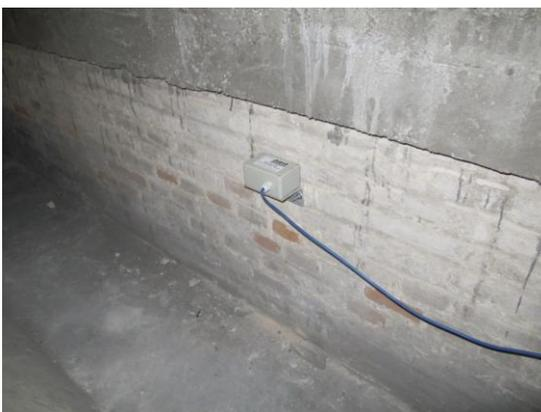
**Fig. 6.4.** Applicazione degli inclinometri.
