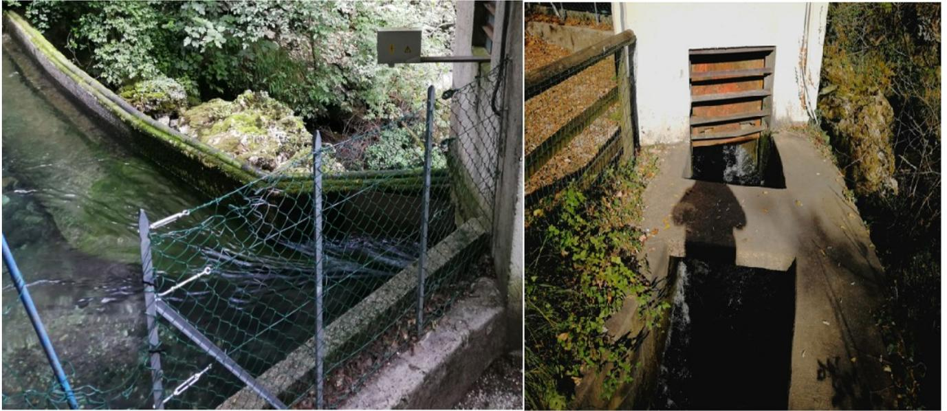
**Foto 5.11:** Immagine della centralina, della paratoia e del muro costruiti nelle immediate vicinanze della sorgente (foto di Luca Dei Cont)
