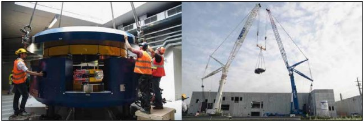
Figura 1.12: immagini dei momenti di installazione del ciclotrone BEST 70p ai LNL.
