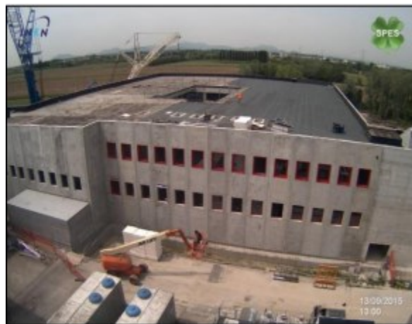
Figura 1.9: edificio SPES in fase di costruzione.
