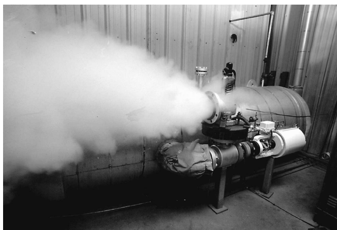
Figura 2.4: Valvole di sfiato in azione
