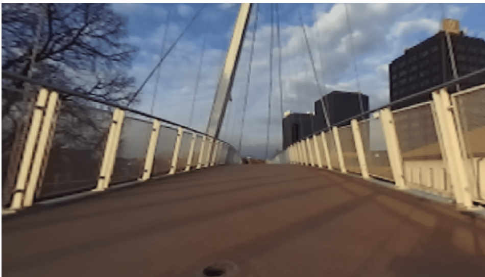
(a) Immagine del ponte.
