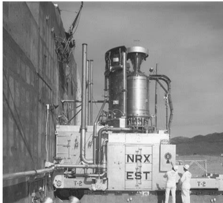
Fig. 7 struttura di testing del motore NERVA, NASA; dal 1964 al 1965. Ad oggi risulta l'unico test condotto a terra.
