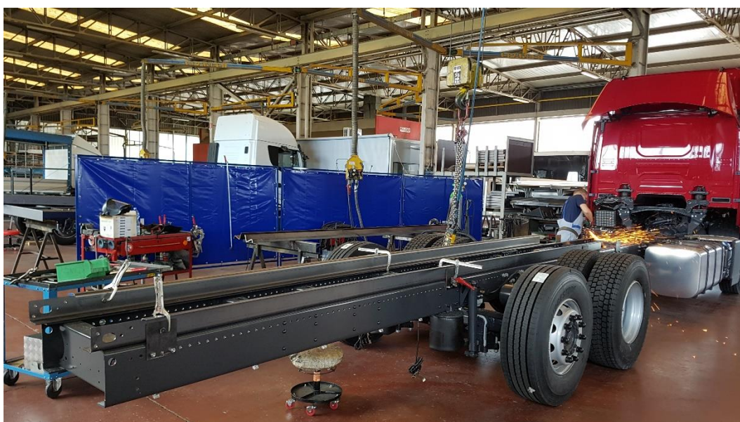
Figura 3.2.1.d Durante fasi iniziali dello sviluppo del controtelaio saldato, un operatore realizza il troncone posteriore separato dall'anteriore.
