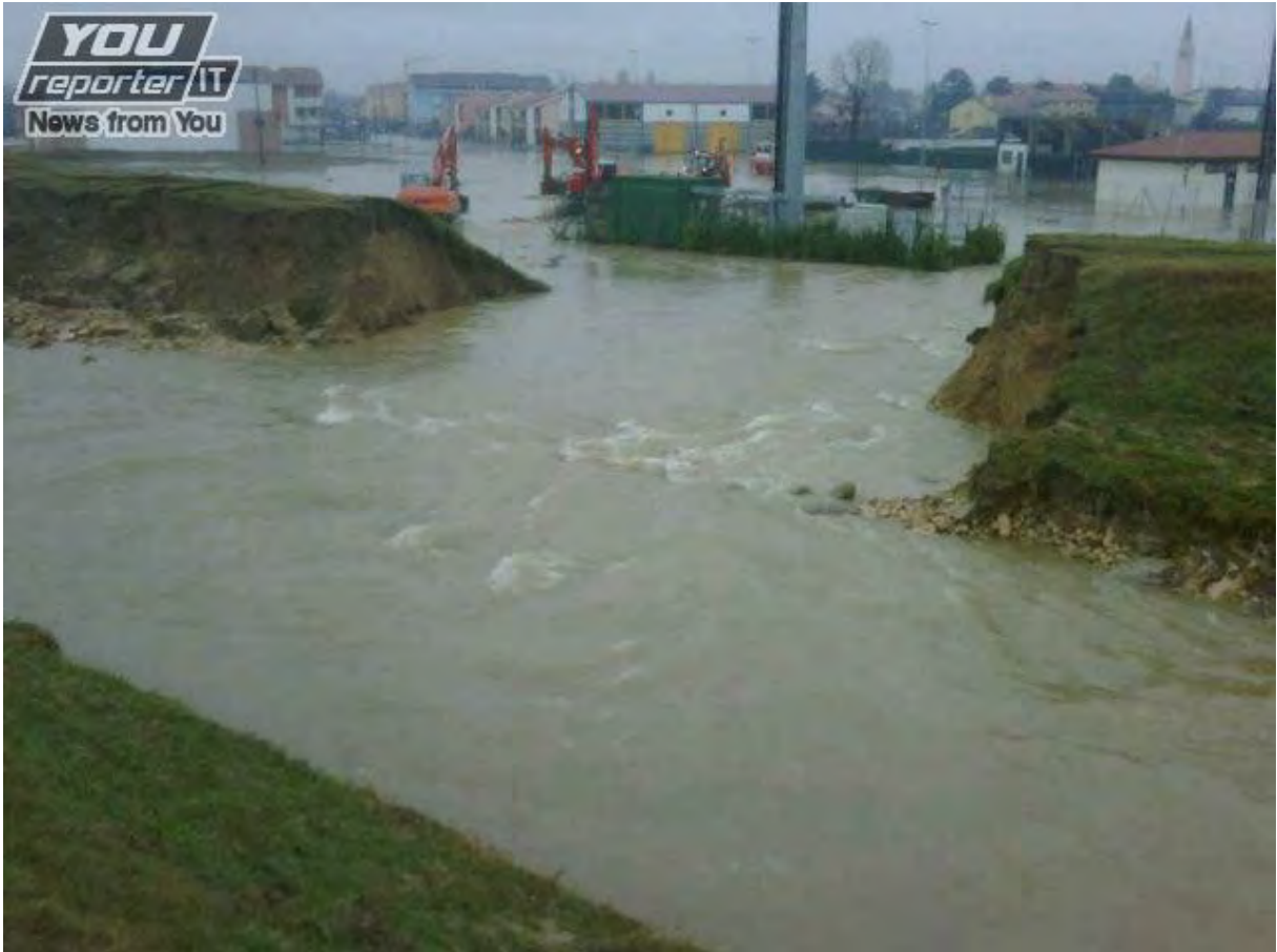
Figura 1.5: breccia arginale eseguita per abbassare il livello del Muson in piena
