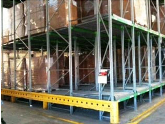
Figura 4.13 : Scaffalatura “a gravità” (entrata canali) in OMP
