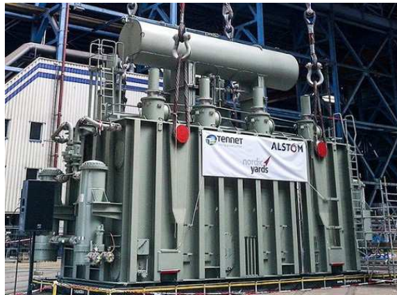
Figura 3.7: Trasformatore utilizzato nelle stazioni di conversione HVDC-VSC.
