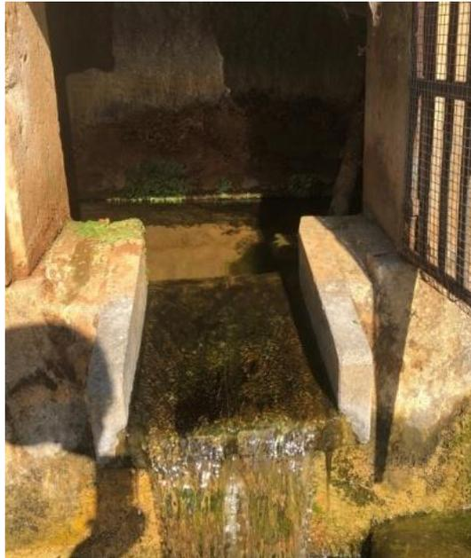
Fig.12: Vasca di raccolta primaria dell'acqua,all'interno è posizionato il CTD-Diver
