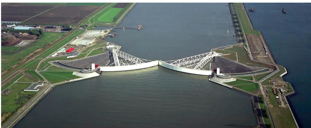
Figura 3.9: Maeslantkering , l'opera sbarramento che protegge Rotterdam e il suo porto dalle inondazioni.
