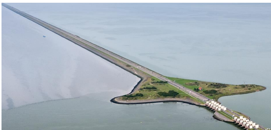
Figura 3.8: la diga di sbarramento Afsluitdijk separa l’Ijsselmeer dal Mare del Nord. Conclusa nel 1932, la diga è attraversata da un’autostrada ed è lunga 32 km, larga 90 metri ed arriva a un’altezza di 7.25 metri sopra il livello del mare. Fonte: Noord Holland 11
