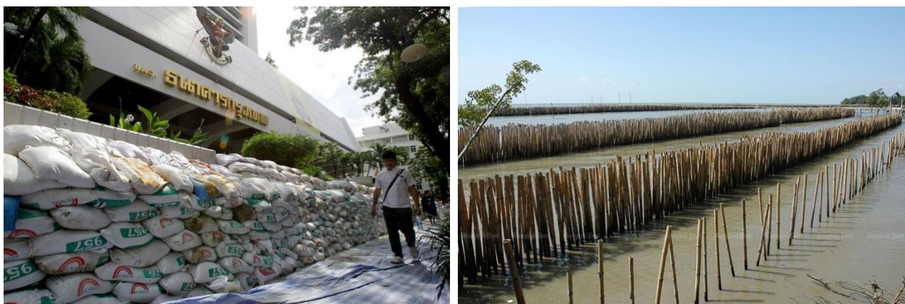
Figura 3.14 e 3.15: (a sinistra) un muro di sacchi di sabbia protegge una banca della capitale thailandese; (a destra) file di canne di bambù impiantate nel fondale marino fungono da barriera contro il moto ondoso, attenuando l'erosione costiera. Fonte: Bangkok Post 12
