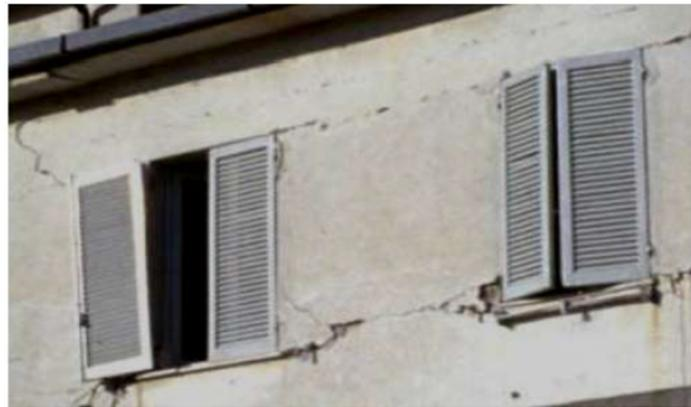
*Figura 2-4 Rottura per pressoflessione di un maschio murario nella zona compressa tra due finestre. La parte di muratura delimitata dalle fessure si comporta come un blocco rigido.*
