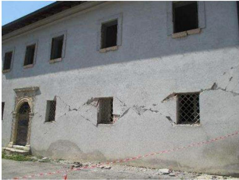
*Figura 2-6 Rottura a taglio dei maschi murari - sisma Centro Italia (2016)*
