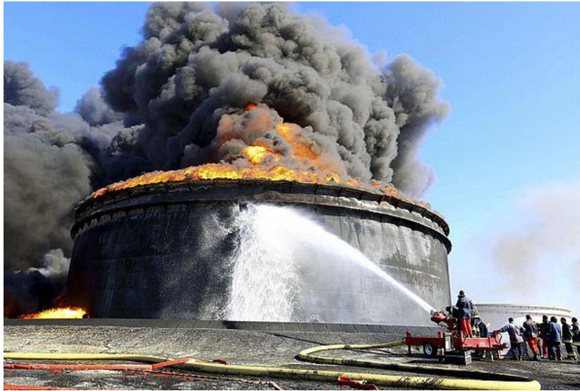
Figura 4.1 Incendio di un serbatoio a tetto galleggiante
