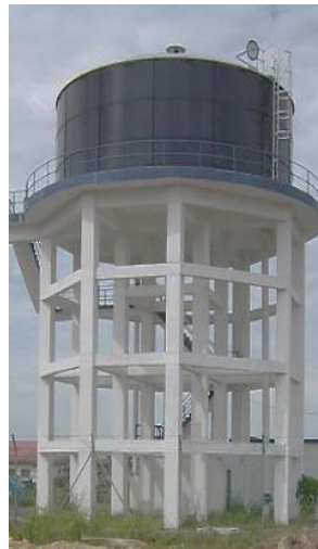
Figura 4.3 Serbatoio sopraelevato con struttura portante reticolare
