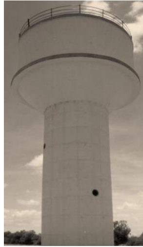
Figura 4.2 Serbatoio sopraelevato con struttura portante a fusto
