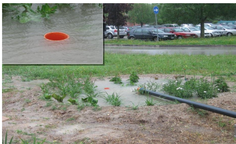
Figura 3.5 Immagine del tubo di troppo pieno e disposizione delle piante all'interno del rain garden piccolo (Simionato, 2011).
