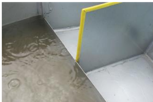
Figura 3.4 Seconda vasca a stramazzo con setto divisorio terminale.
