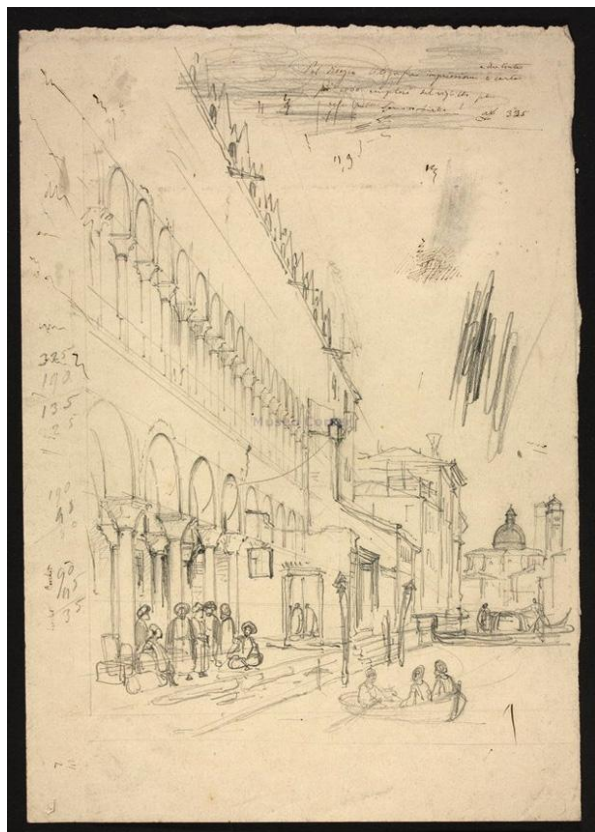
(fig. 2.2) Veduta della facciata del Fondaco dei Turchi sul Canal Grande, Pividor Giovanni, XIX sec.
