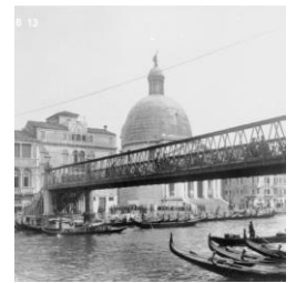
(fig. 1.5) Foto storica del Ponte degli Scalzi, 1914
