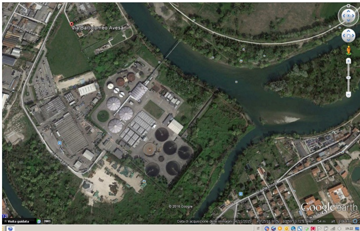
Figura 1.1: vista aerea dell'impianto di depurazione "Città di Verona"
