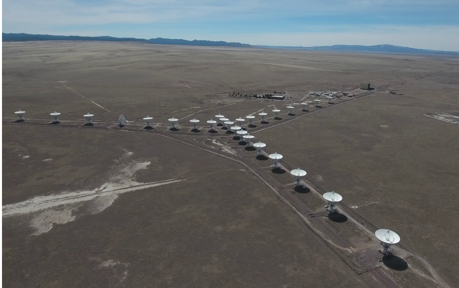
Figura 2.4: Baseline del Very Large Array dove si può notare chiaramente la forma ad Y del sistema.
