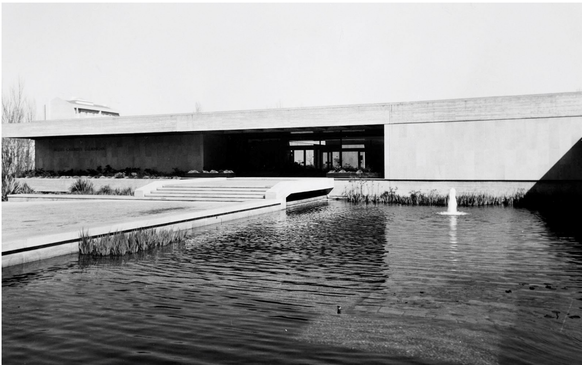
Figg. 12 e 13 - Mário de Oliveira, Veduta del Museo Calouste Gulbenkian, 1970. Progetto del Museo realizzato dagli architetti Ruy Jervis d'Athouguia , Pedro Cid e Alberto Pessoa, mentre i giardini sono stati realizzati dagli architetti paesaggisti: Gonçalo Ribeiro Telles e António Viana Barreto.
