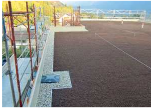
Fig. 6.8. Bordo di ghiaia con elemento di separazione in alluminio (Fonte Climagrün Srl - coperture a verde)
