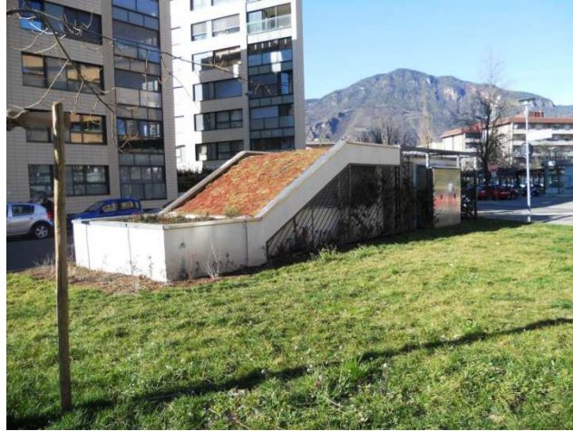
Fig. 7.7. Tetto verde posto su centrale elettrica del quartiere Casanova a Bolzano
