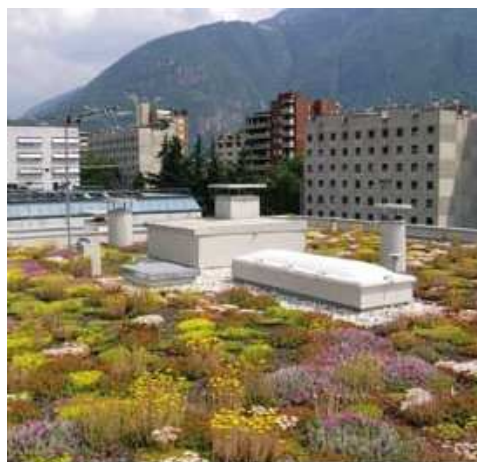
Fig. 5.5. Inverdimento estensivo sul tetto dell'Istituto per l'edilizia sociale in Via Druso, Bolzano (Fonte: Diego del Monego)
