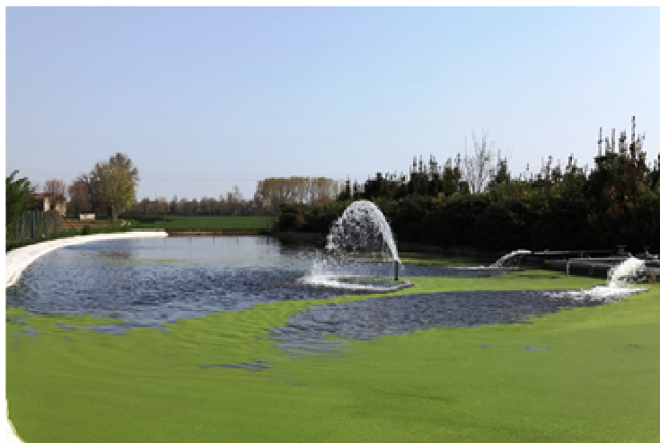
Fig. 3.2. Impianto di lagunaggio aerobico (fonte: www.centrovenetoservizi.it )
