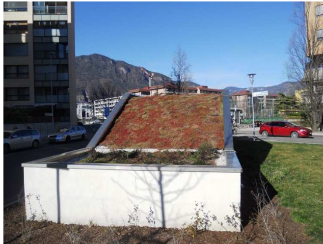
Fig. 7.8. Tetto verde sistemato su centrale elettrica del quartiere Casanova a Bolzano
