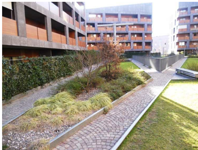
Fig. 7.3. Verde pensile zona interna quartiere Casanova a Bolzano
