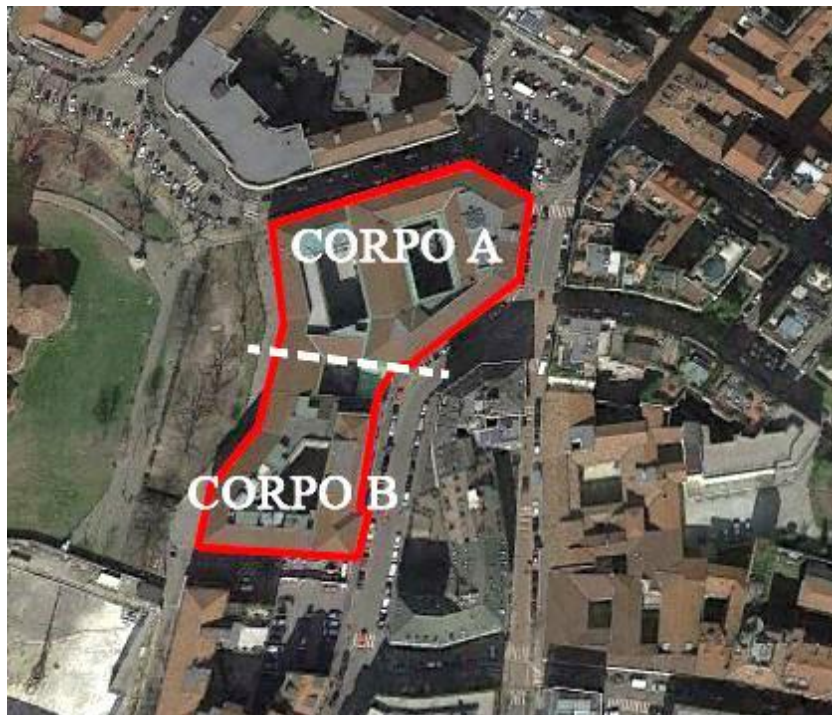
Figura 9: Vista aerea del cantiere di grosse dimensioni, divisione Corpo A e Corpo B.
