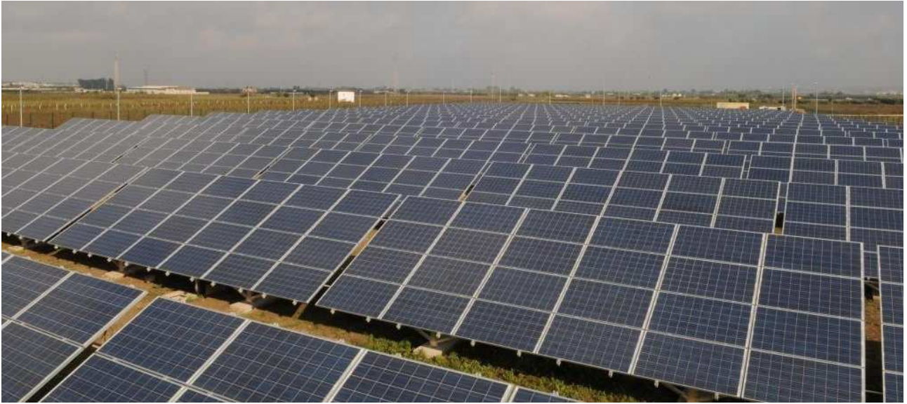
Figura 3.3: Veduta del campo fotovoltaico; Si identificano le strutture assemblate di 6x4 pannelli, denominate vele , che affiancate compongono i filari .
