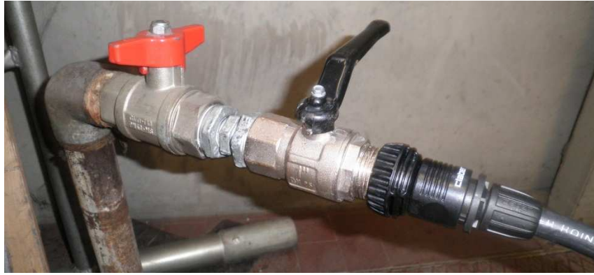
Figura 5.3: Particolare del sistema di derivazione dell'acqua: si riconoscono i 2 rubinetti a sfera e il raccordo per il tubo collettore.
