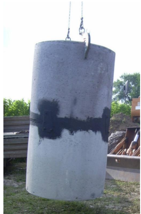
Figura 2.2: Vasca in calcestruzzo per sistema BAG durante la posa in opera.
