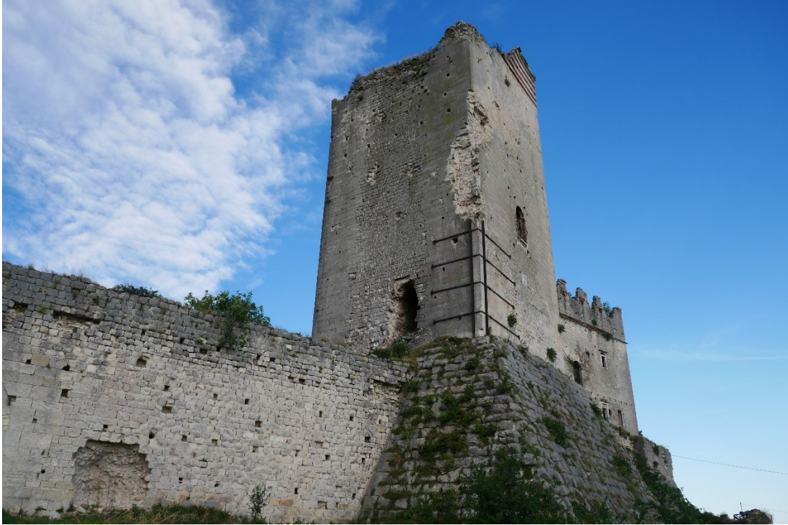
Figura 1.15. Fotografia dell'esterno della torre.
