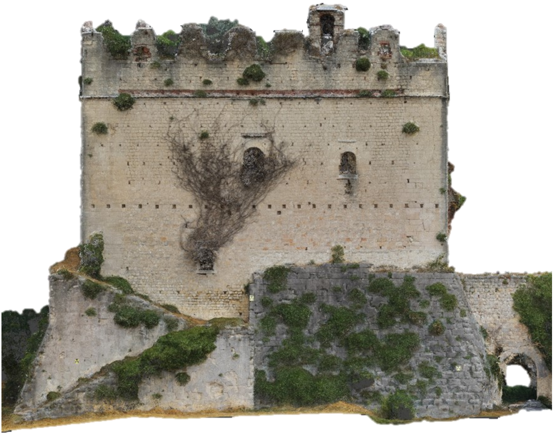
Figura 1.22. Prospetto sud del palazzo.
