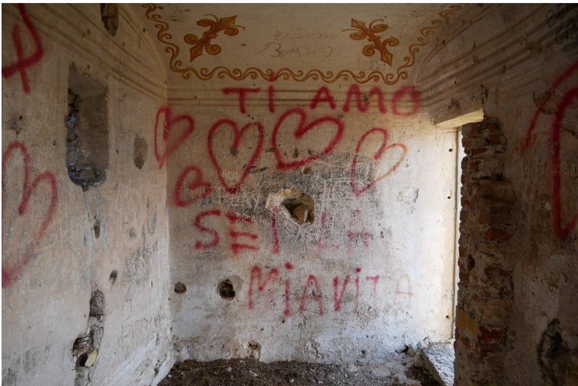
Figura 1.14. Fotografia della stanza interna al muro a est del palazzo.
