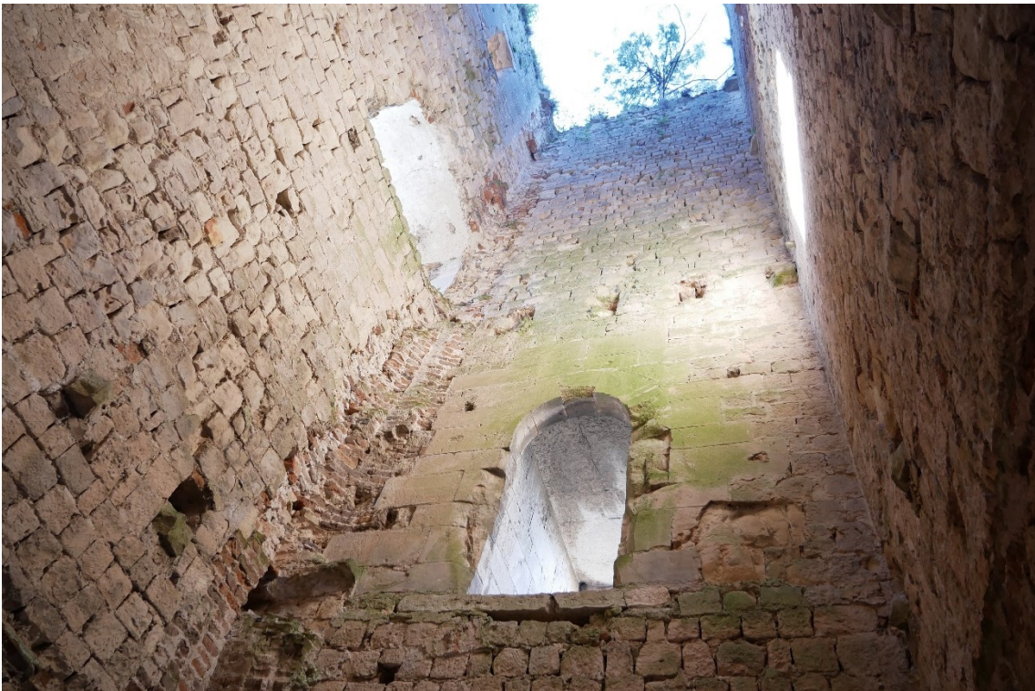
Figura 1.16. Fotografia dell'interno della torre.
