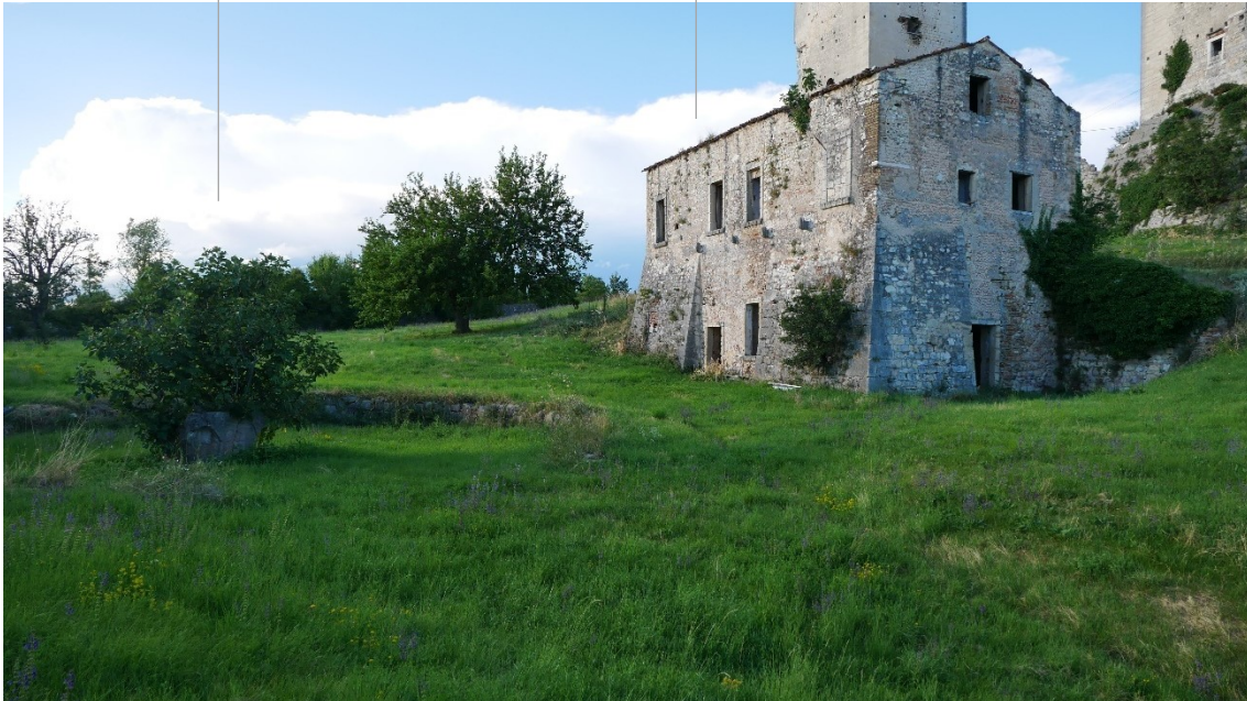
Figura 1.17. Fotografia della cisterna di età veneziana e della casa colonica.
