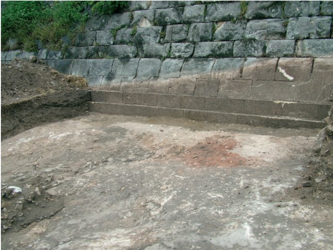
Figura 2.29. Fondazione della scarpa del palazzo a sud (da I castelli di Montecchio Maggiore, Marastoni C., 2011).
