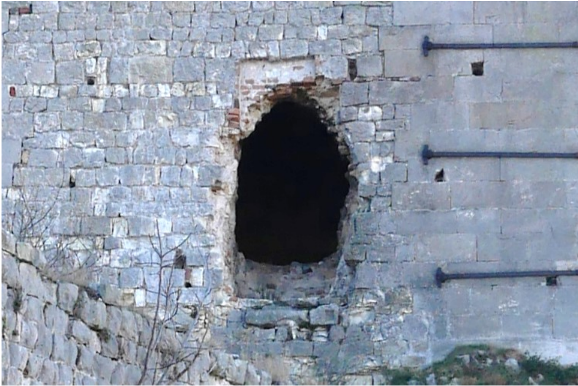
Figura 2.42. Particolare dell'apertura sulla parete verticale a nord della torre.
