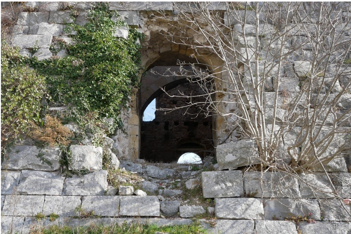
Figura 2.41. Particolare dell'apertura sulla scarpa a ovest del palazzo.
