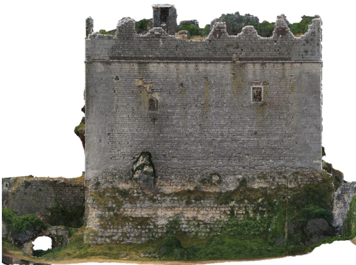
Figura 1.24. Prospetto nord del palazzo.
