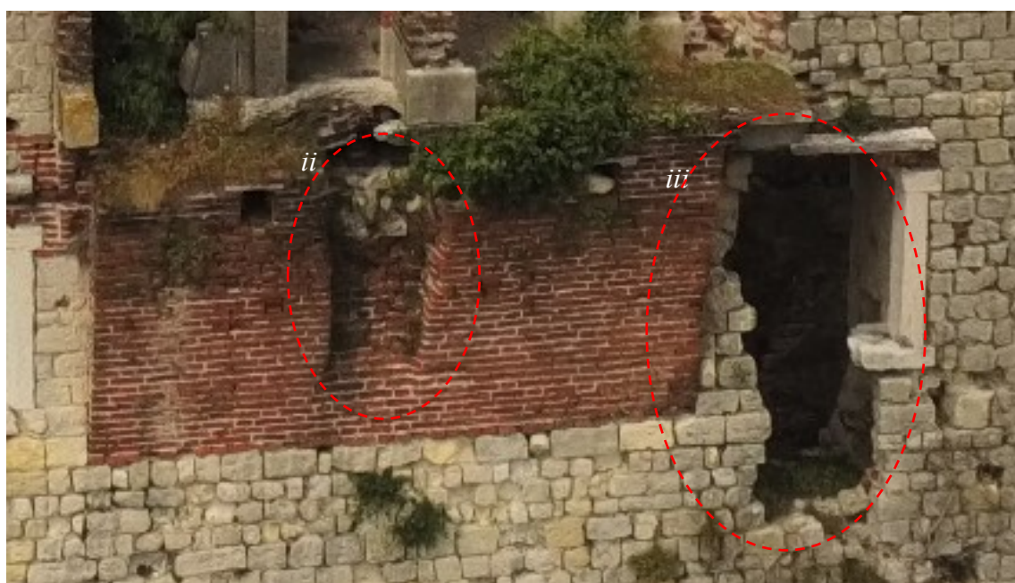
Figura 2.37. Dettagli ii, iii degli elementi di dissesto nel prospetto est del palazzo.
