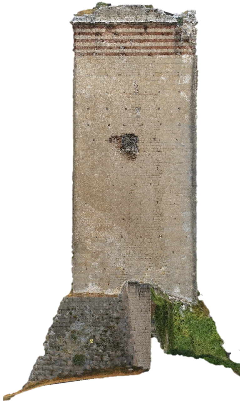
Figura 1.26. Prospetto sud della torre.
