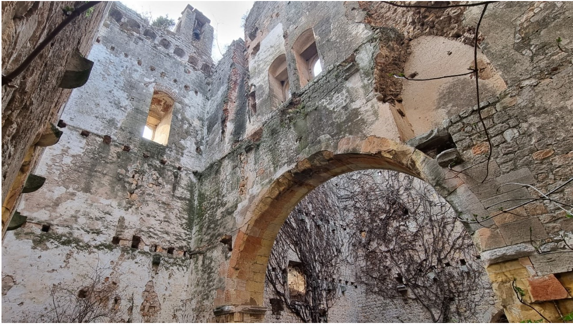
Figura 1.13. Fotografia dell'interno del palazzo, lato est.
