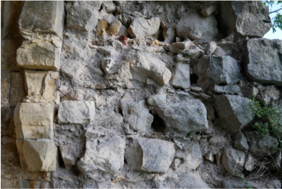
Figura 2.26. Particolare dell'apertura a ovest del palazzo dove si osserva la discontinuità tra parete verticale e scarpa, e parziale ingranamento tra nucleo e paramento esterno della scarpa.
