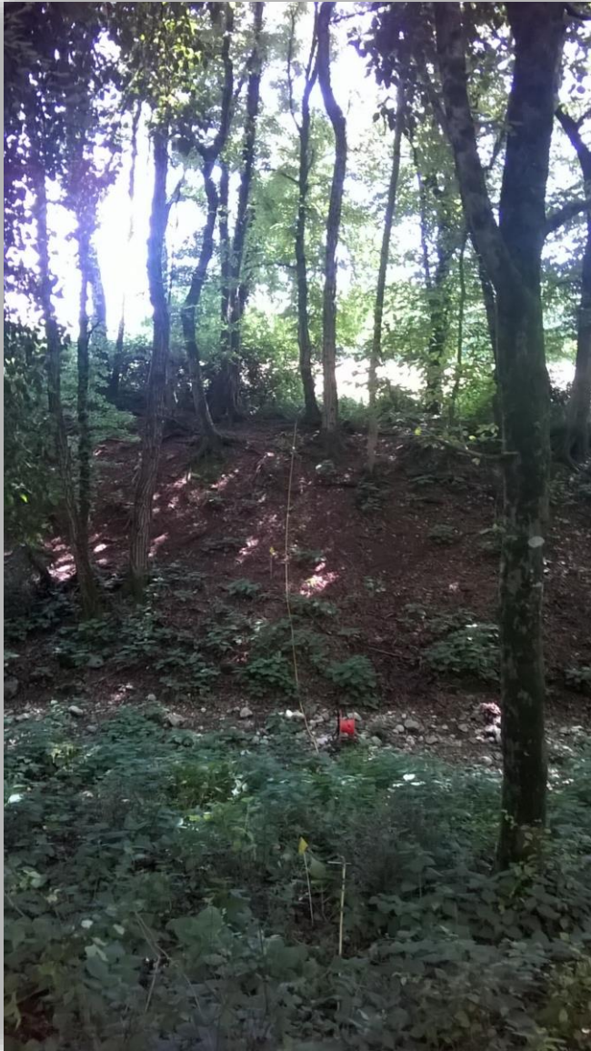
Fig.26 – Stendimento cavo multiconduttore lungo terreno sconnesso
