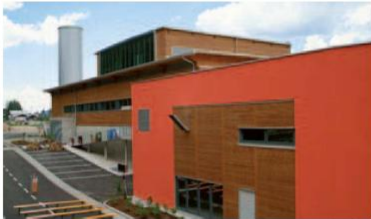
Centrale di teleriscaldamento di Dobiacco – San Candido
