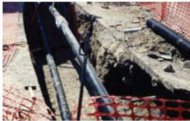
Realizzazione rete di teleriscaldamento
