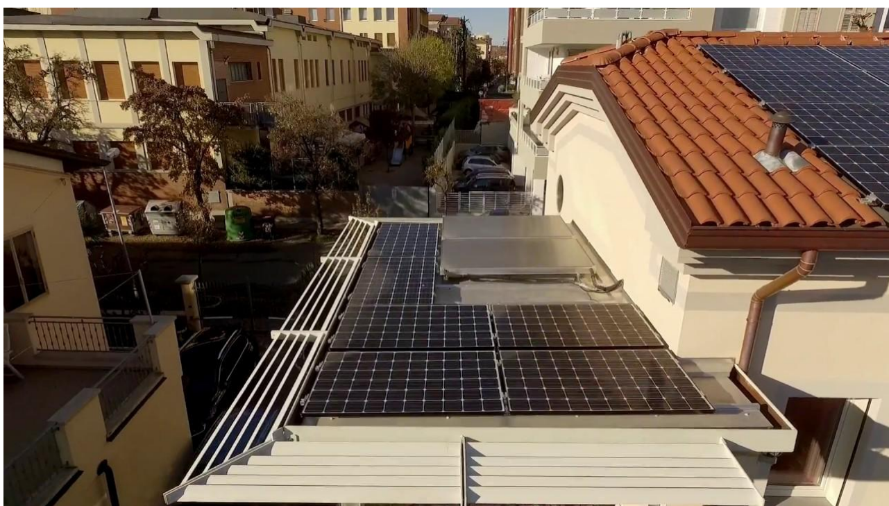
Figure 24,25. Foto esterne edificio (Fonte: https://gbcitalia.org/certificazione/gbc-home/gbc-home-progetti )
