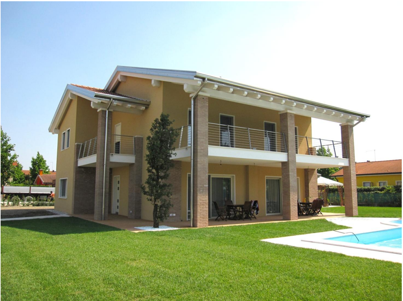
Figura 5. Foto esterna edificio (Fonte:archivio realizzazioni “Studio Carturan Architecture&Engineering”)
