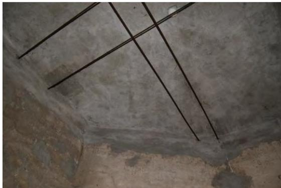
Fig. 6.47. La fotografia, realizzata il 26 gennaio 2015, mostra il posizionamento dei quattro tiranti rispetto ai lati della torretta, di forma ottagonale.
