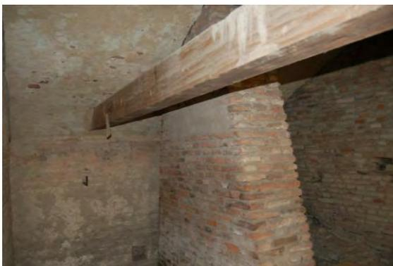
Fig. 9.2. Nell'immagine, effettuata il 20 novembre 2014, mostra una delle travi in legno che rivestono le catene metalliche presenti all'interno della cripta e le pareti della cripta la cui tessitura muraria è ben esposta.
