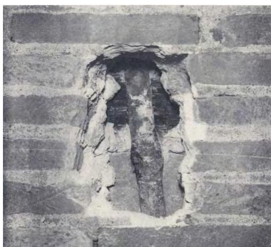
Fig. 3.28. L’ancoraggio del paletto di una delle catene trecentesche costituito superiormente da una trave di legno e inferiormente da un blocco di trachite visibili dal foro praticato all’esterno della parete; FABBRI COLABICH, PROSDOCIMI, SACCOMANI, *I recenti lavori*, cit., Fig. 13.
