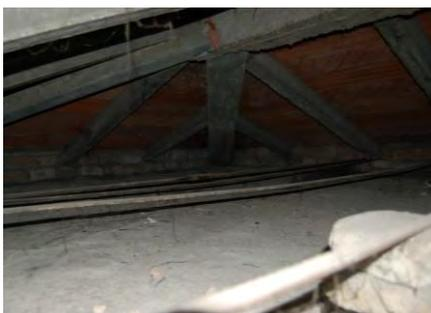
Fig. 9.22. Nell'immagine del 26 gennaio 2015 si possono vedere le travi ed i travetti in calcestruzzo del sottotetto della loggia.
