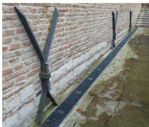
Fig. 6.32. La fotografia del 15 ottobre 2014 mostra i tre capochiave presenti all'esterno del prospetto di nord-ovest.
