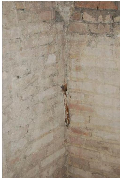
Fig. 6.44 - 6.45. Nella fotografia di sinistra si può vedere il capo chiave della catena presente all'interno della muratura tra locale sopra il presbiterio e torretta, in questo caso all'angolo con la facciata di nord-est. La foto di destra mostra invece il capo chiave all'angolo con la facciata di sud-est; le fotografie sono state realizzate il 26 gennaio 2015. (Per la collocazione puntuale si veda la tav. 6.17 del book di tavole allegato).
