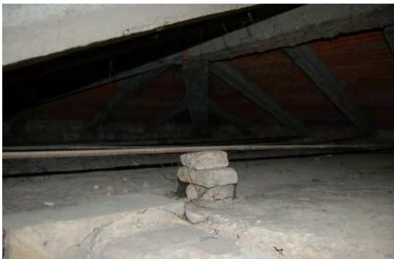
Fig. 5.31. La ripresa fotografica, realizzata il 26 gennaio 2015, mostra il sottotetto della loggia. Si possono osservare le strutture dei solai ed i relativi tiranti. (Si veda cono visivo n.4 tav. 4.07).
