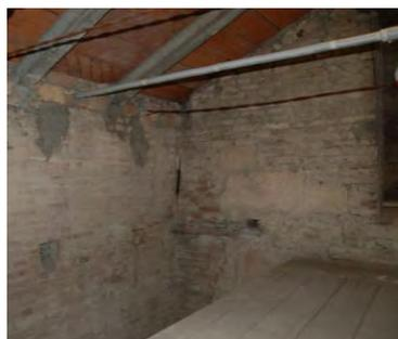
Fig. 9.23. Nell'immagine del 26 gennaio 2015 si possono vedere i travetti in calcestruzzo del sottotetto del locale soprastante il presbiterio.
