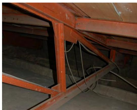
Fig. 6.24. La fotografia, realizzata il 15 ottobre 2014, mostra lo stato attuale delle capriate, le piastre saldate che collegano tra loro le aste. Si possono notare anche le terzere
