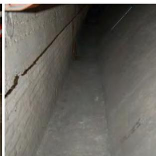
Fig. 9.24. Nell'immagine del 26 gennaio 2015 si può vedere il cordolo del sottotetto della navata.
