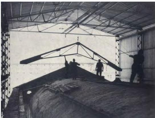
Fig. 3.20. Il sollevamento di una nuova capriata metallica con il paranco scorrente sulla guida sostenuta dalle incavallature della tettoia provvisoria; FABBRI COLABICH, PROSDOCIMI, SACCOMANI, *I recenti lavori*, cit., Fig. 23.
