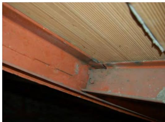
Fig. 6.26. La fotografia, realizzata il 15 ottobre 2014, mostra il collegamento tramite bulloni tra le terzere e i puntoni. Il manto di copertura in tavelloni è posto al di sopra delle terzere.
