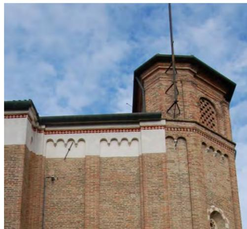
Fig. 6.41. La fotografia del 20 novembre 2014 mostra il capochiave della catena sottostante l'arcone in muratura del locale sopra il presbiterio, presente esternamente sul prospetto di sud-est.
