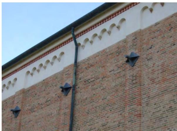
Fig. 6.36. La fotografia, realizzata il 20 novembre 2014, mostra il posizionamento degli ancoraggi disposti centralmente rispetto il punto medio delle lesene.
