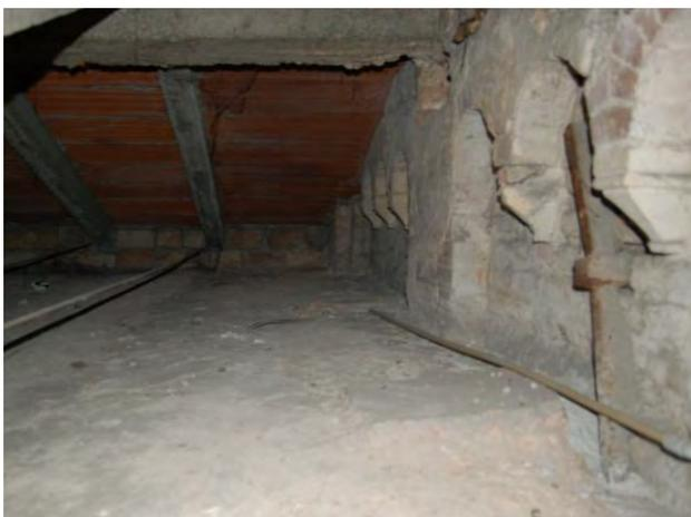
Fig. 6.40. La fotografia del 26 gennaio 2015 mostra (sulla destra) il capochiave della catena sottostante l'arcone in muratura del locale sopra il presbiterio, presente nel sottotetto della loggia, nella parete in comune con il sopracitato locale.
