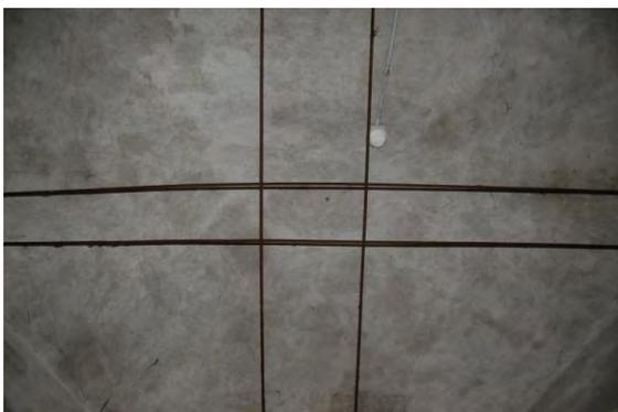
Fig. 6.46. La fotografia, realizzata il 26 gennaio 2015, mostra i quattro tiranti presenti all'interno della torretta sopra l'abside.
