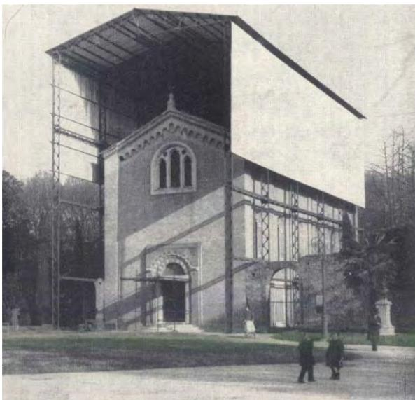
Fig. 3.16. La tettoia metallica provvisoria a montaggio finito realizzata nell'estate del 1962; FABBRI COLABICH, PROSDOCIMI, SACCOMANI, *I recenti lavori*, cit., Fig. 7.
