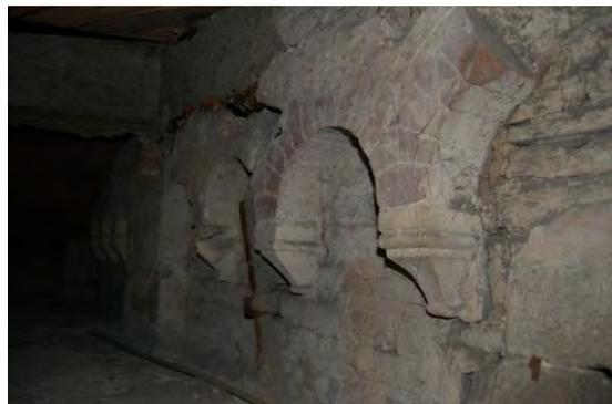
Fig. 5.32. La ripresa fotografica, realizzata il 26 gennaio 2015, mostra le decorazioni presenti nel sottotetto della loggia, del tutto uguali a quelle presenti all'esterno dell'edificio. Si può anche notare il capo chiave della catena presente nel sottotetto del locale soprastante il presbiterio. (Si veda cono visivo n.23 tav. 4.08).
