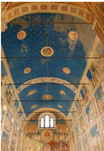
Fig. 6.38. La fotografia del 20 novembre 2014 mostra il posizionamento delle cinque catene della navata e di quella sottostante l'arco trionfale posto tra navata e presbiterio.
