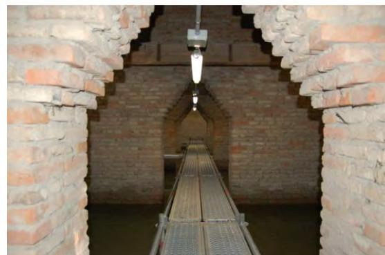
Fig. 5.24. La ripresa fotografica, realizzata il 20 novembre 2014, raffigura la serie di setti murari ed una delle travi cave contenente una catena (Si veda cono visivo n.6 tav. 4.01).
