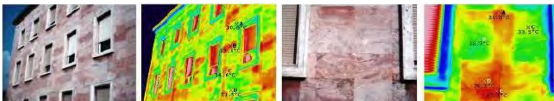
Fig. 10.9. E' possibile rilevare la presenza di distacchi e difetti sotto la superficie di lastre di rivestimento in pietra del palazzo del primo ministro albanese a Tirana. La presenza di aria sotto le pietre è indicata da una concentrazione di temperature più elevate, la differenza tra queste caratterizza le zone distaccate da quelle ancora attaccate (differenza di circa 5°C). BINDA, CANTIN, CUCCHI, *Thermovision: applications in conservation*, cit., p.8, Fig. 7.
