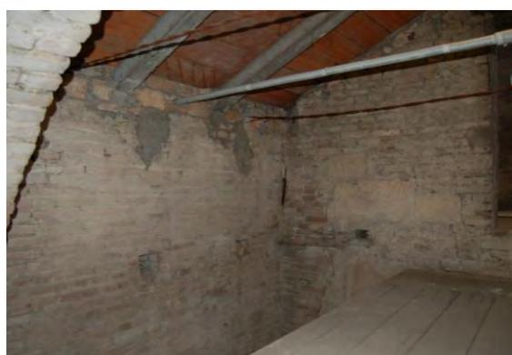
Fig. 6.27 - 6.28. Le fotografie, realizzate il 15 ottobre 2014, mostrano la copertura del presbiterio: si possono vedere i travetti in calcestruzzo, la relativa trave di colmo ed i tavelloni che formano il manto di copertura.
