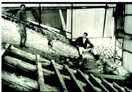
Fig. 3.19. Rimozione della copertura in legno, trattino fotografia nel corso dei lavori 1961-63; MODENA, *Aspetti costruttivi e strutturali*, cit., p. 115, Fig. 15.
