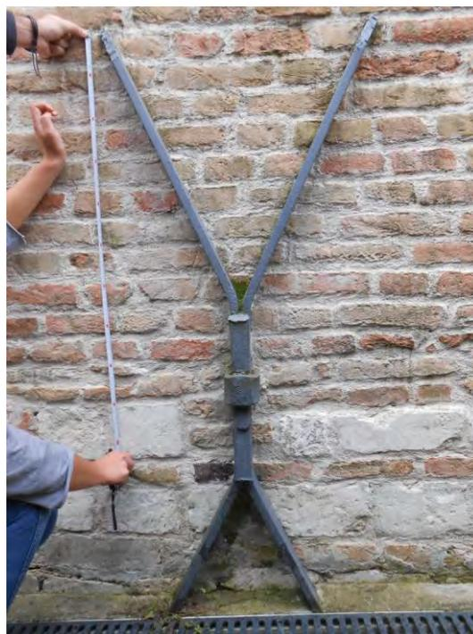
Fig. 5.3. Misurazione con cordella metrica del capochiave di una delle tre catene presenti nella cripta, fotografia del 15 ottobre 2014.
