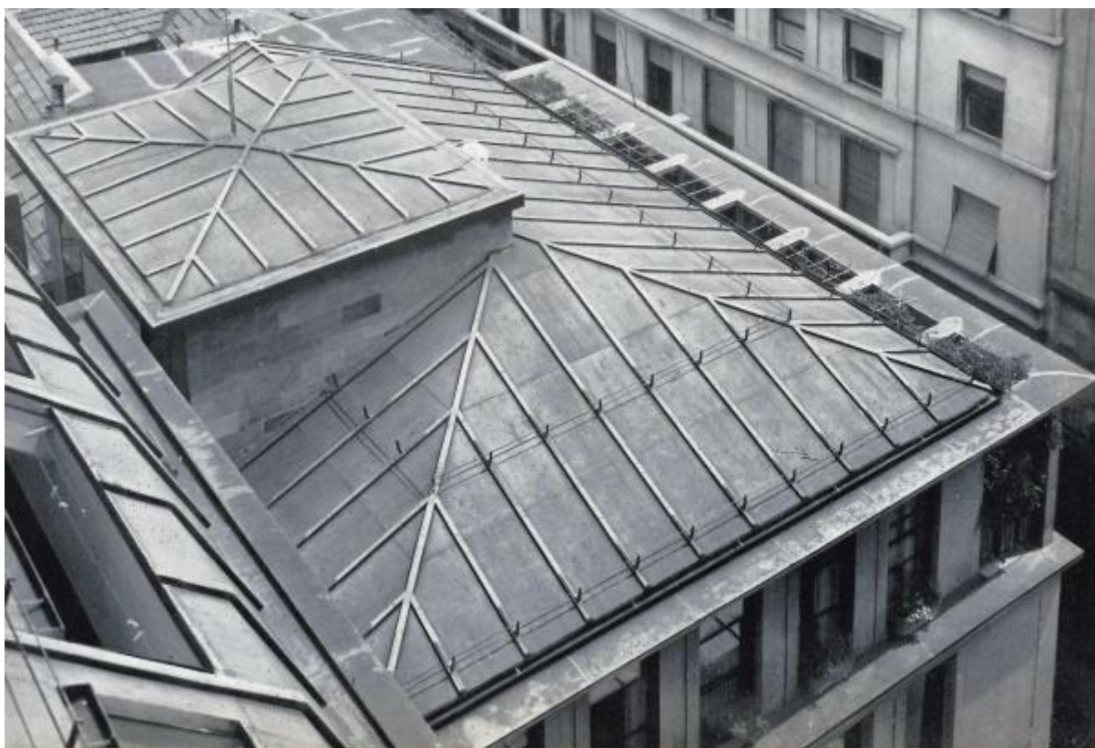
Esempio di copertura a giunzione verticale
