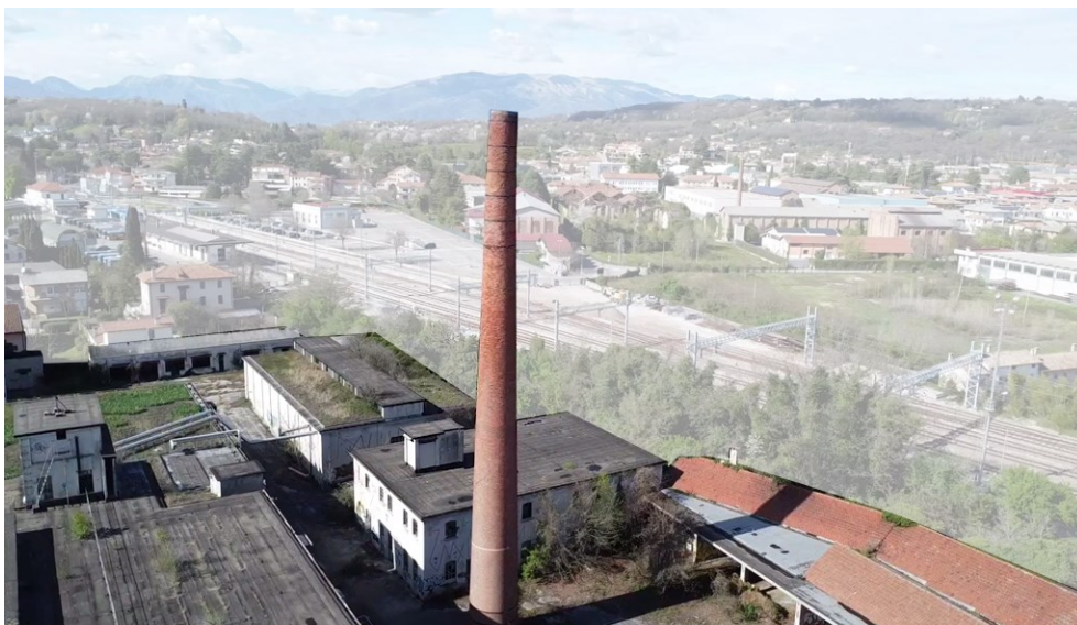
37- Vista aerea da sud (fonte: NVP Studios Production)
