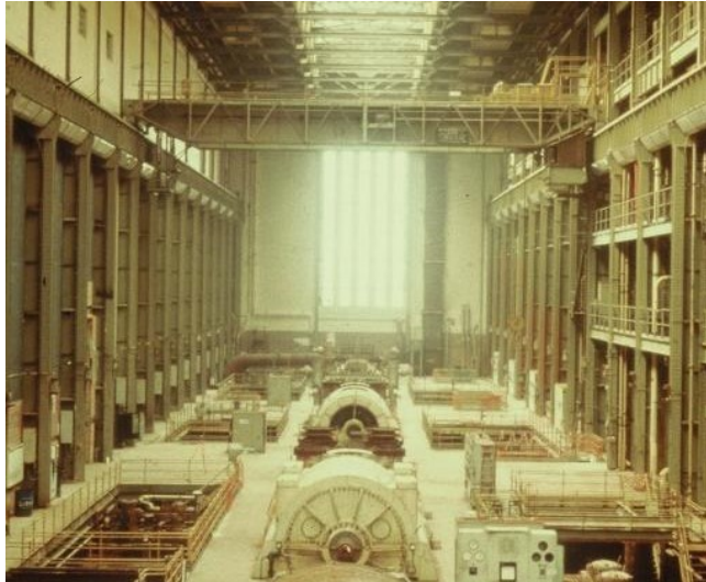
6- Sala turbine prima dell'intervento (fonte:tate.org)
