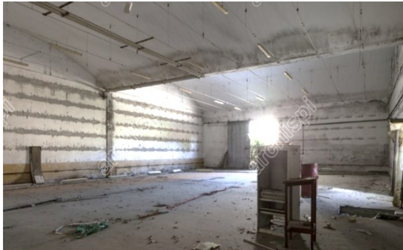
45- Vista interna del corpo C (fonte: Archispi)
