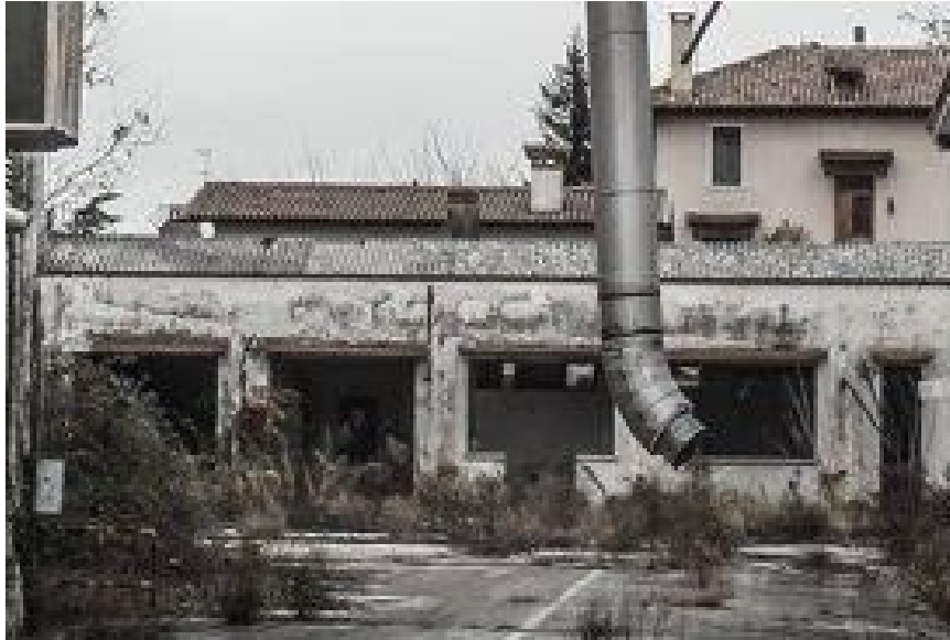
53- Vista esterna corpo G (fonte: I luoghi dell'abbandono)
