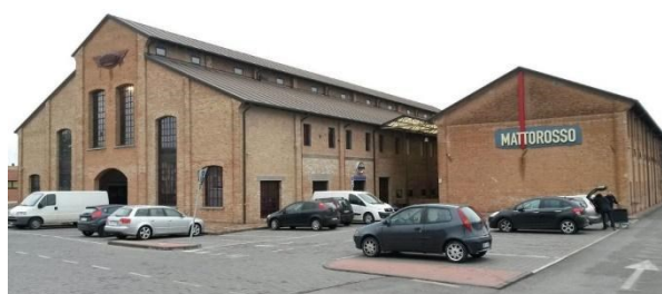
33-Vista esterna dopo (fonte: Mountech)
