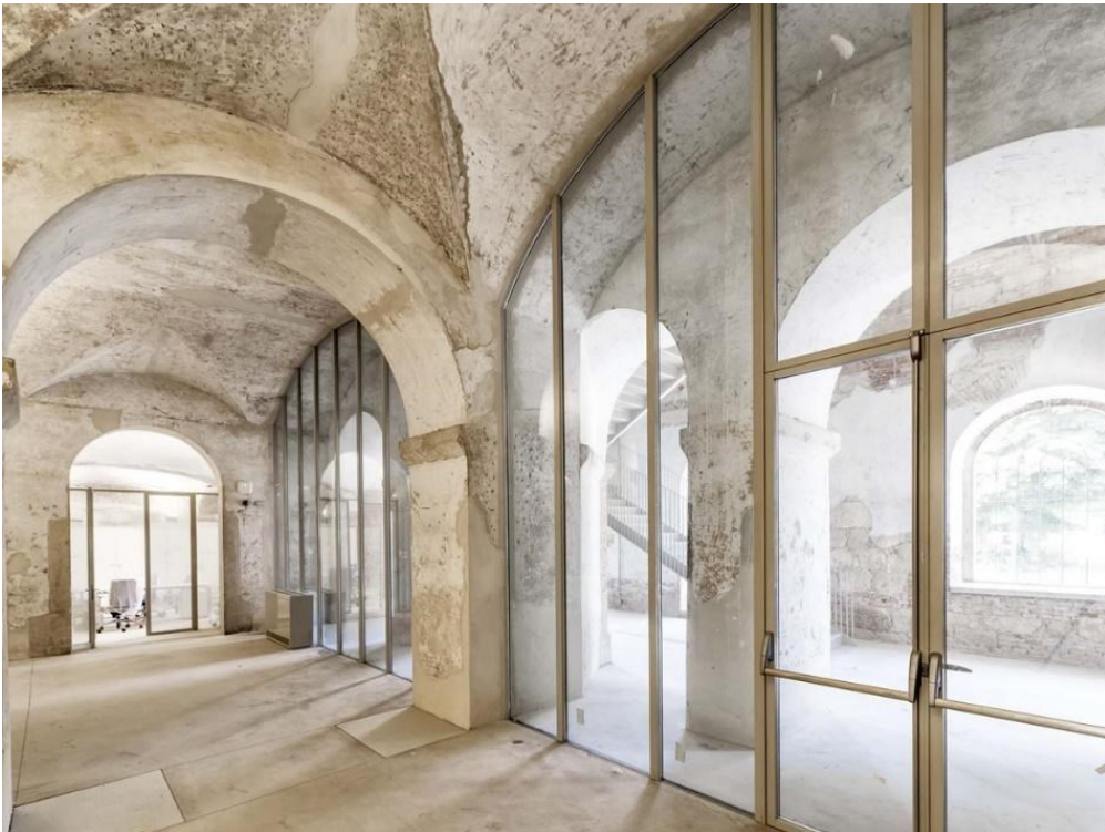
30- Vista interna per piano terra (fonte: Mogs)
