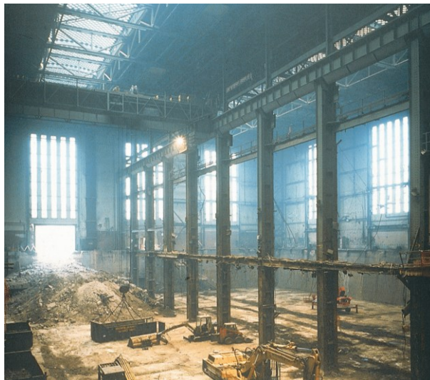
7- Sala turbine durante lo smantellamento interno (fonte: Marcus Leith)
