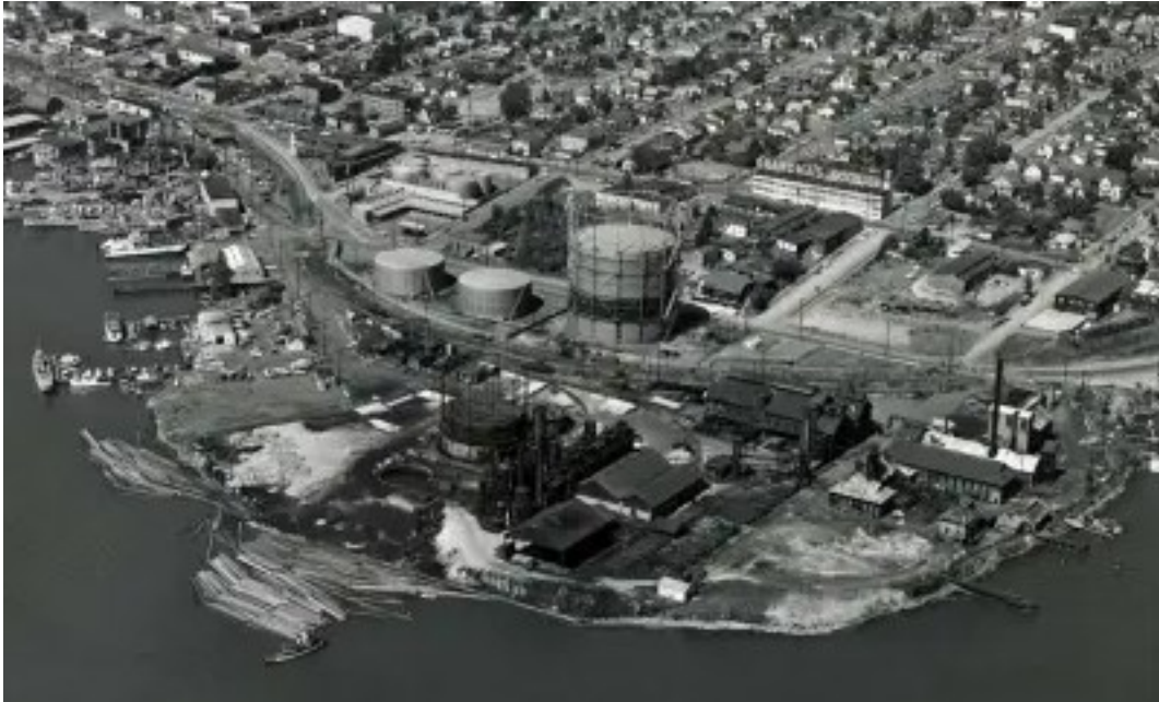
1 -Gas Works, Seattle. Vista aerea delle rovine del gasometro degli anni '60 (fonte: Seattle Police Department)
