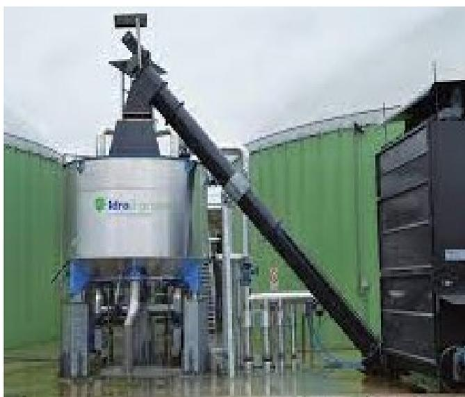
*Figura 2.1.3: Pulper installato in un impianto di biogas: si osservano le linee di carico delle matrici solide e del digestato per la diluizione, nonché le linee di scarico verso il digestore (Fabbri, 2013)*
