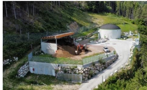
*Figura 3.2.6 e 3.2.7: Impianto consortile di Predazzo. Nelle immagini si distinguono il gasometro parzialmente interrato ed il sito di stoccaggio della materia solida di scarto della digestione dei liquami*
