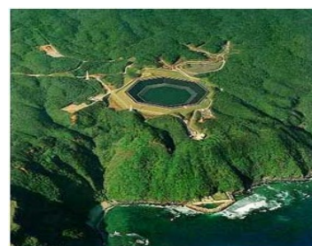
Figura 18 Impianto di pompaggio marino a Okinawa
