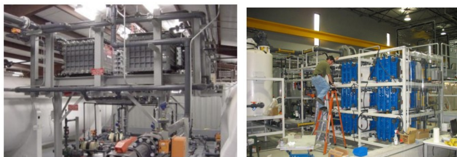
Figura 53 Esempio di impianti di accumulatori VRB, dalla configurazione concettuale a quella commercialmente disponibile in moduli
