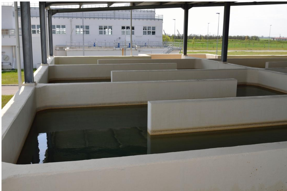
Figura 10. Vasche a serpentina relative all'impianto della Standiana, trattate con biossido di cloro.
