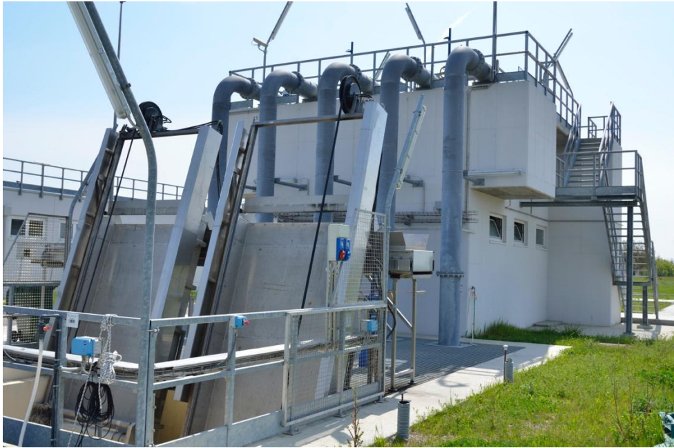
Figura 8. Macchinario che permette la grigliatura nell'impianto della Standiana.
