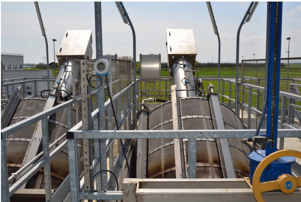
Figura 9. Macchinario atto alla staccatura su griglie a tamburo rotante relativo all'impianto della Standiana.
