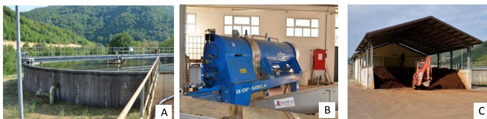
Figura 7. Ispessitore (A), centrifuga (B) e fanghi palabili (C) relativi all'impianto di Capaccio.
