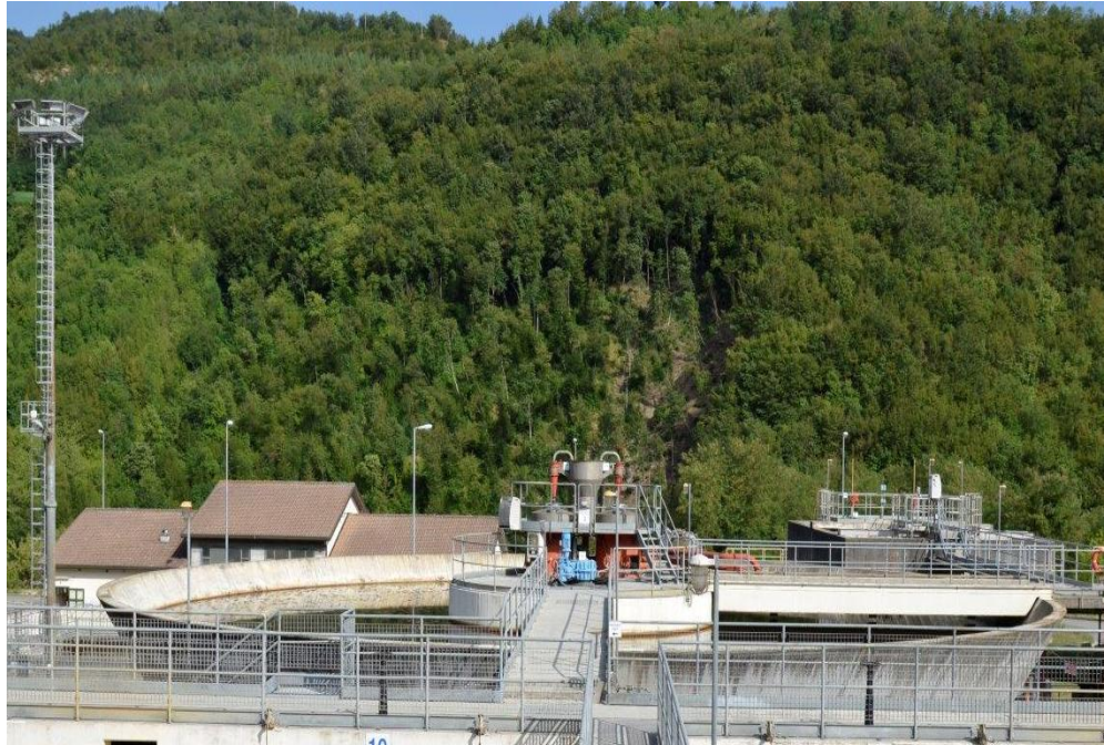
Figura 5. Chiariflocculatore relativo all'impianto di Capaccio dove avviene l'immissione del PAC.
