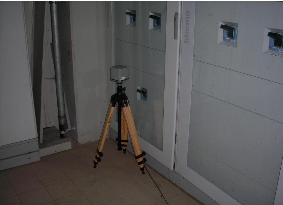
Fig. 2.4 Esempio di misura in bassa frequenza in prossimità della cabina elettrica
