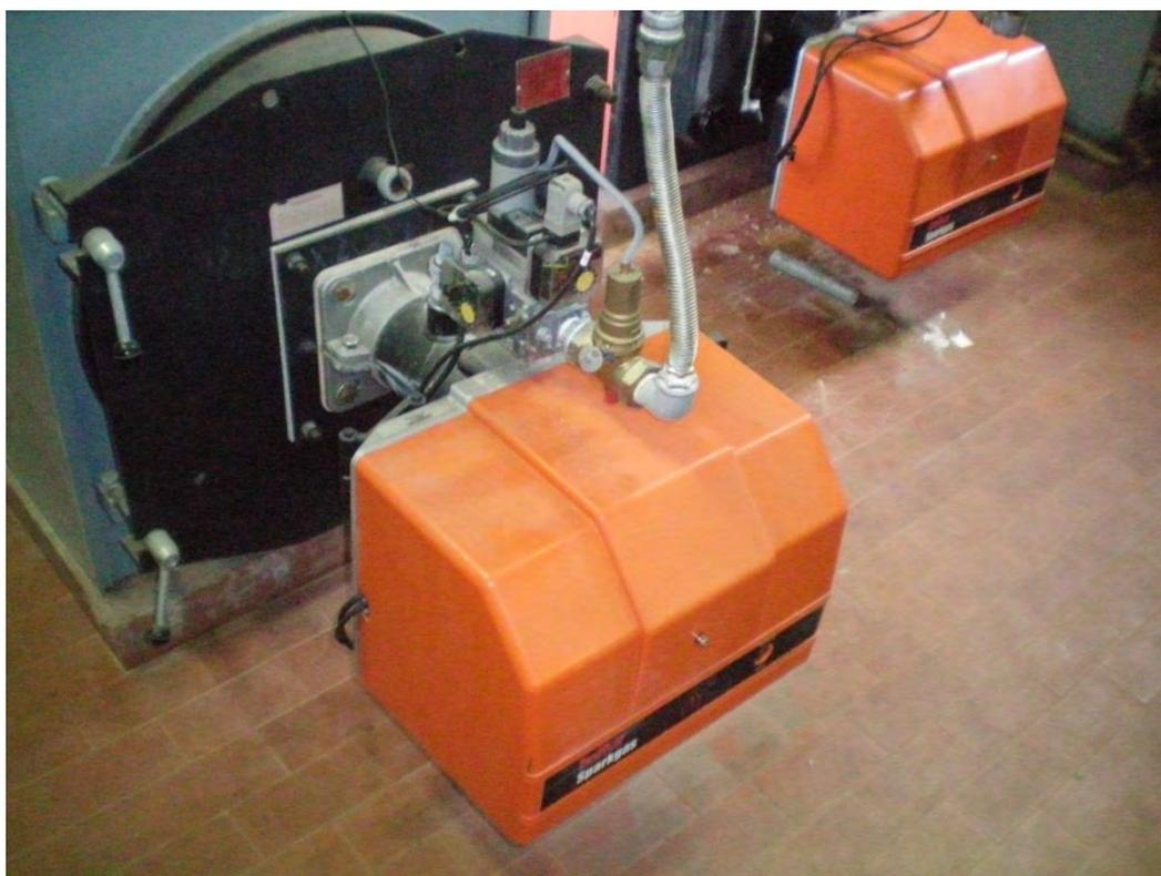
Figura 5.1.2.2 generatore e bruciatore della caldaia dell'Hotel San Faustino
