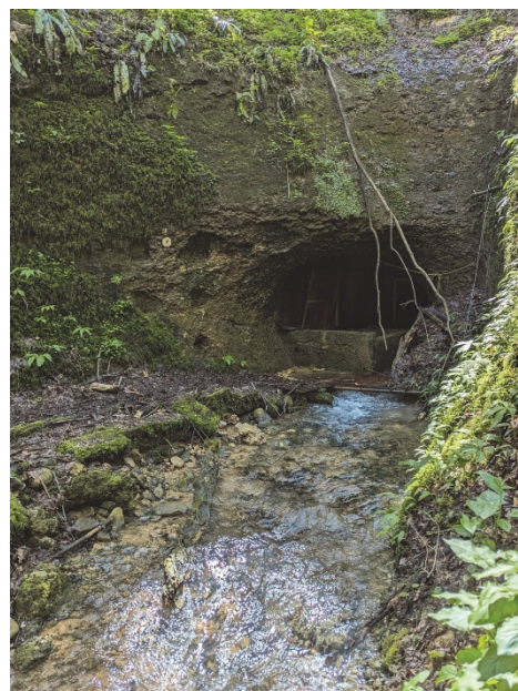
Figura 25: Apertura della cavità per raggiungere l'inizio della sorgente Tavarano Lungo
