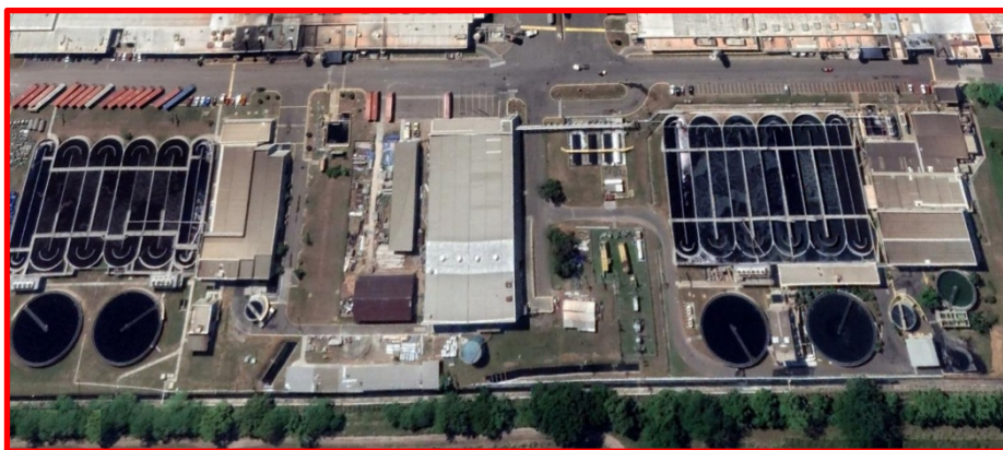
Figura 1. Impianto di Depurazione (vista panoramica)
