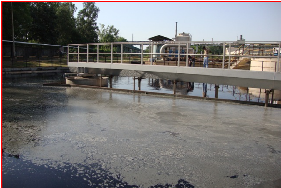
Figura 10. Sedimentatore dei reflui
