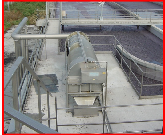
Figura 5. Grigliatura a tamburo (vista laterale)
