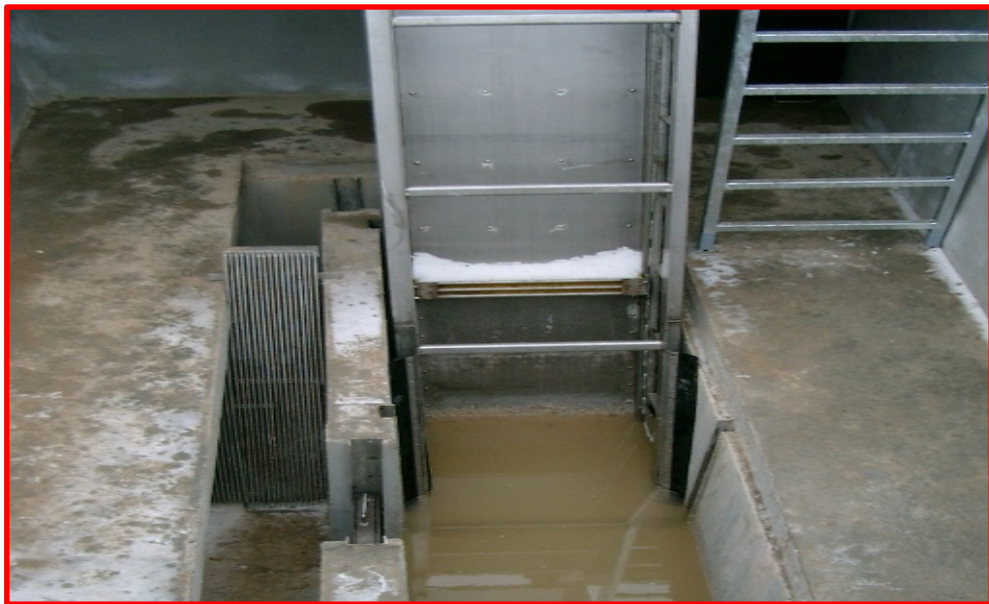
Figura 2. Grigliatura con pendenza
