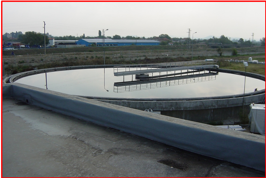
Figura 11. Vasca per ispessimento dei reflui
