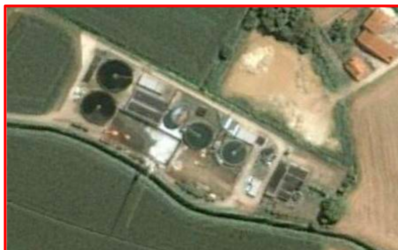
Figura 9. Impianto di depurazione di San Bonifacio
