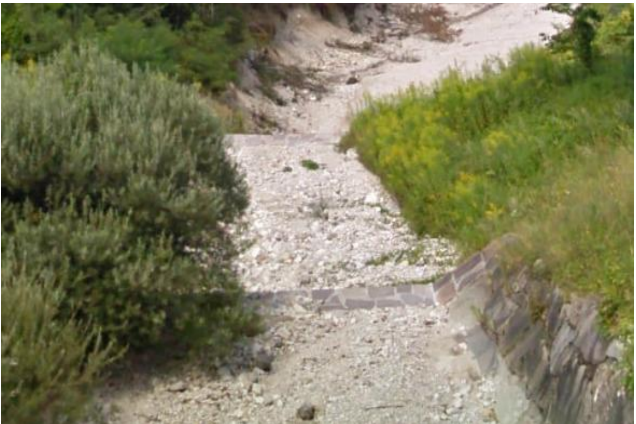
Fig. 5.10 Tratto tra la briglia 7 e la 9 nel quale è stato rilevato il diametro maggiore degli elementi dispersi.
