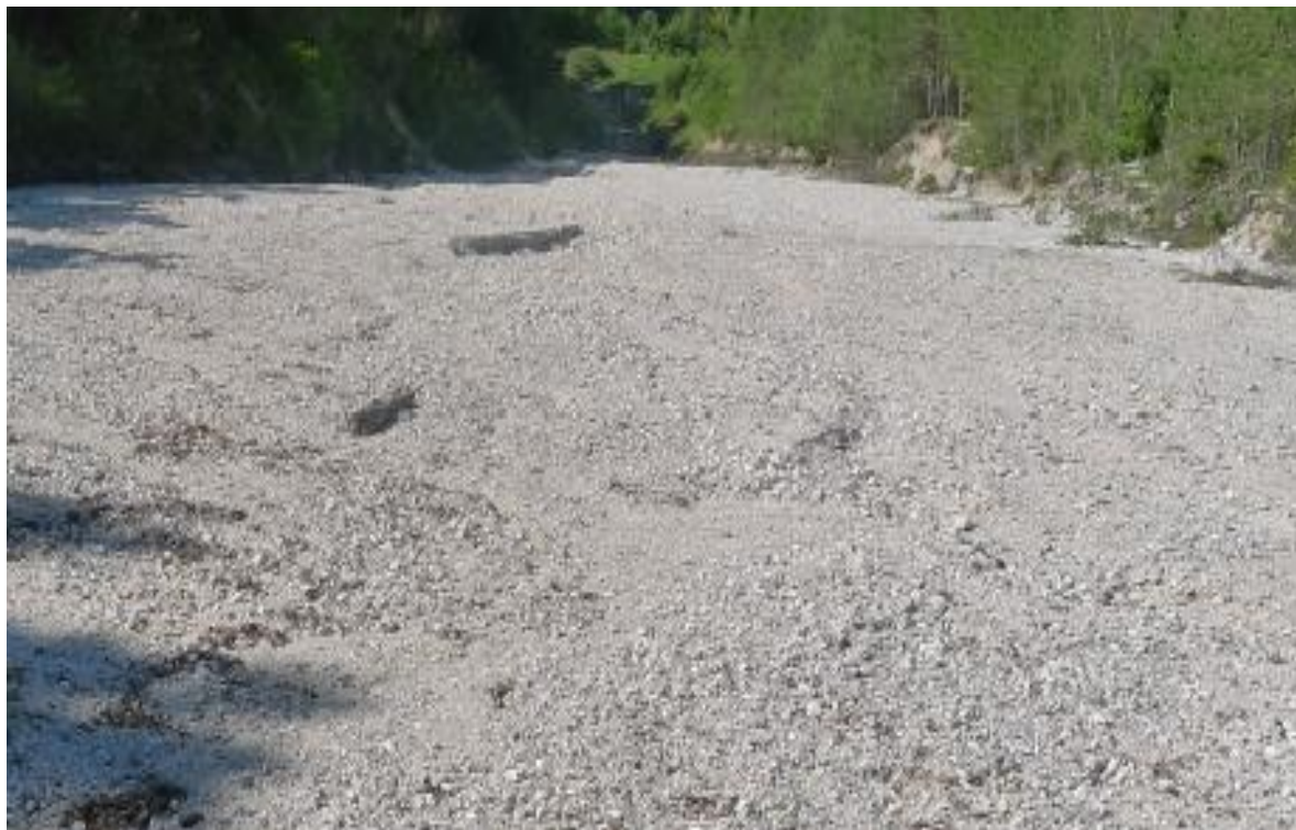
Fig. 6.24 Piazza di deposito della briglia filtrante.
