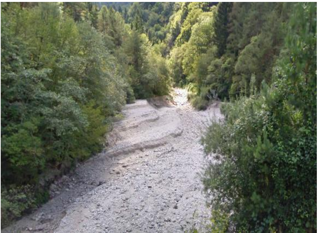
Fig. 5.23 La piazza di deposito centrale vista dal ponte della Strada Provinciale.
