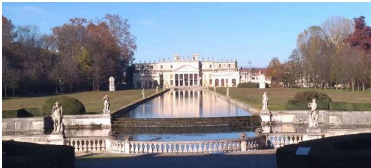
Fig. 8.11: Il parco della villa.
