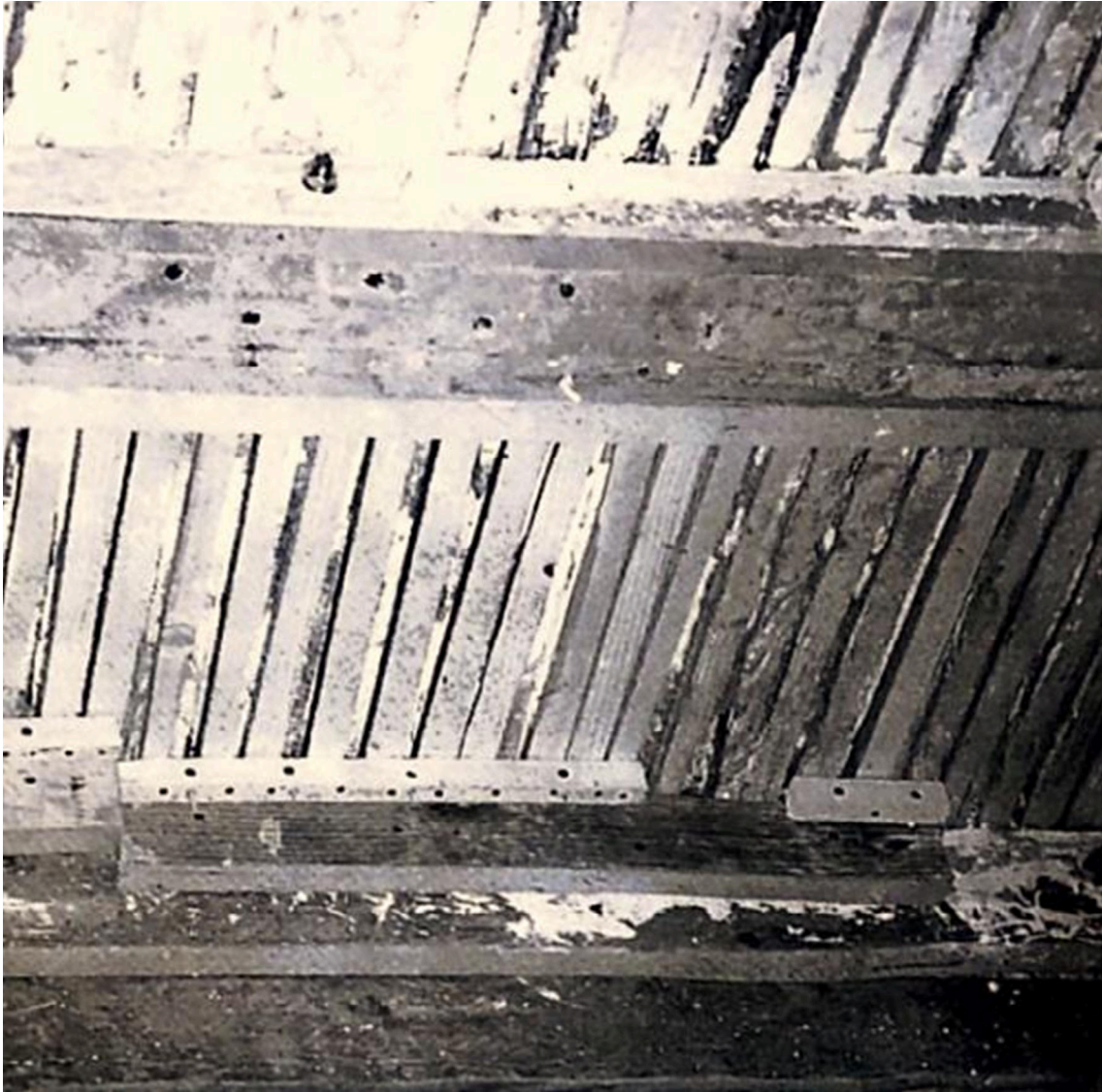
Fig. 8.18: Reintegrazione delle arelle del soffitto nella stanza di Napoleone. [Fonte: Rallo G., 2000]
