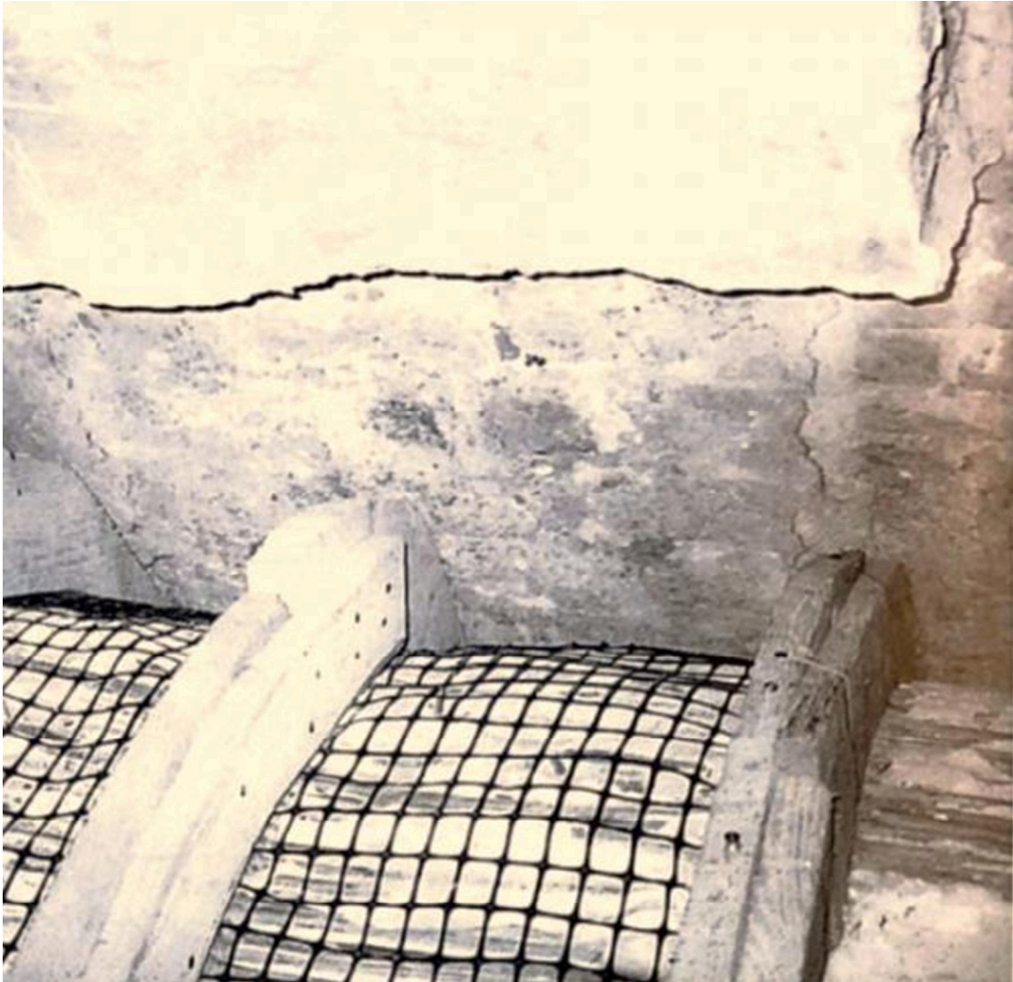
Fig. 8.19: Predisposizione rete polipropilene per il consolidamento del soffitto della stanza di Eugenio Beauharnais. [Fonte: Rallo G., 2000]
