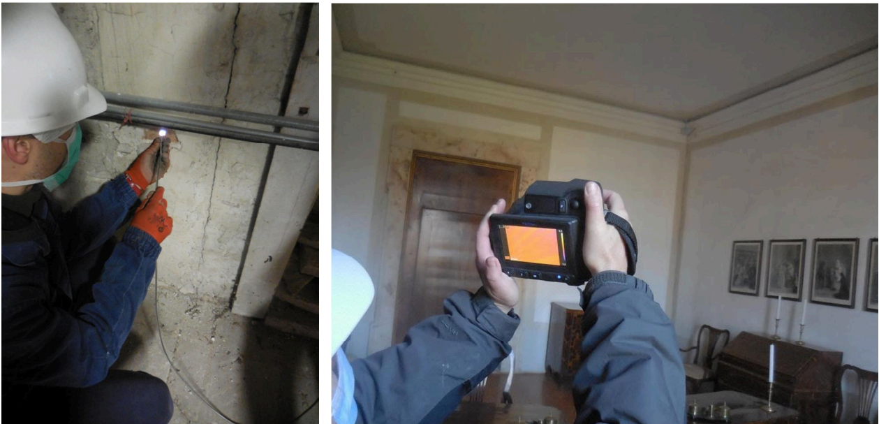
Fig. 9.1: Rilievo esteso con indagini endoscopiche e termografiche del 26/11/2020.
