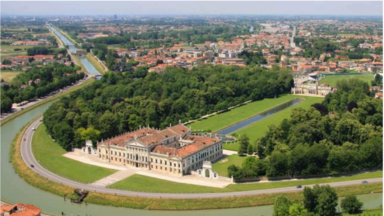
Fig. 7.4: Foto aerea di Villa Pisani da Sud-Est. Poco più indietro si vede l'area residenziale di Stra mentre nello sfondo vi sono i comuni di Noventa Padovana a sinistra e Vigonza a destra. Lungo l'argine vi è la Strada Regionale 11 Padana Superiore (in questo tratto Via Doge Pisani) sulla quale si affaccia l'ingresso principale a Villa Pisani. [Fonte: sito web Villa Pisani - https://www.villapisani.beniculturali.it/galleria ]
