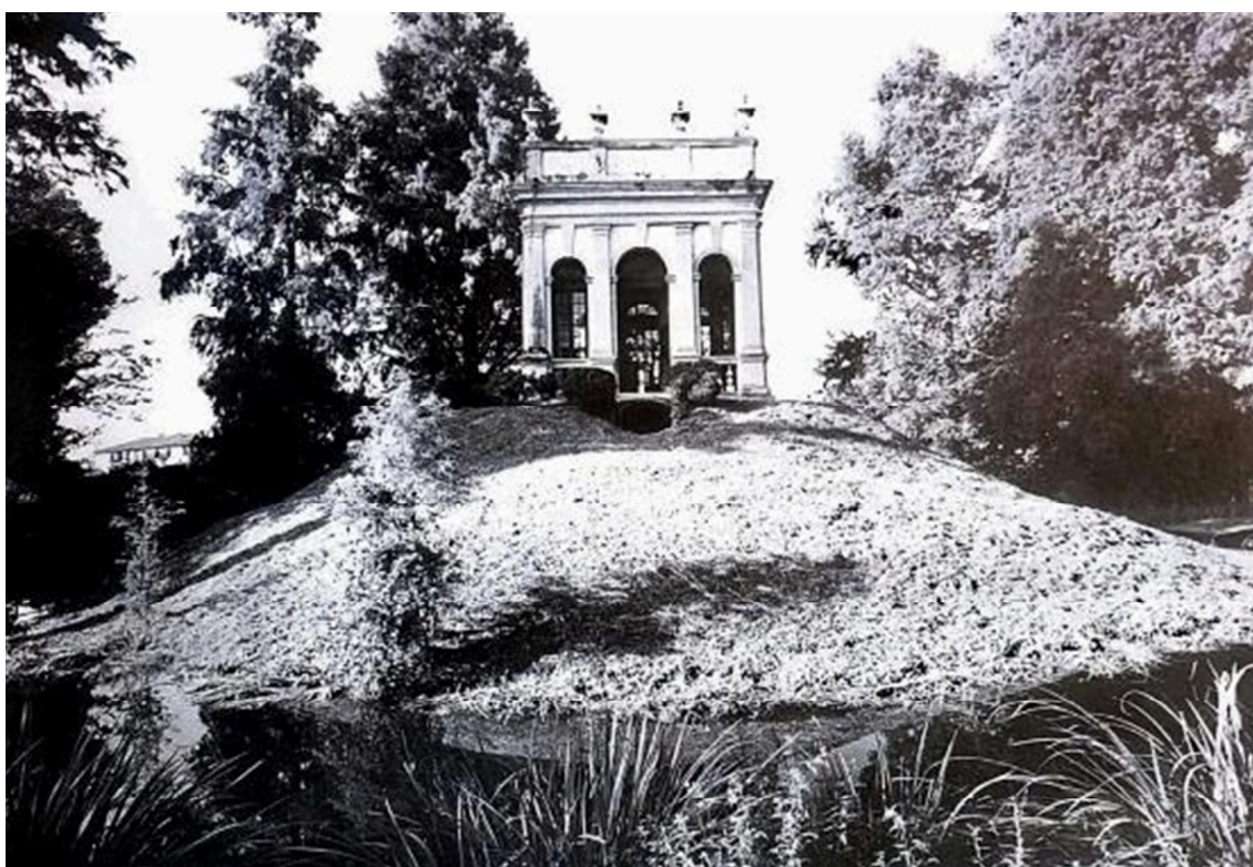
Fig. 8.15: La coffee-house prima del restauro del 1993-94, fronte sinistro. [Fonte: Rallo G., 2000]
