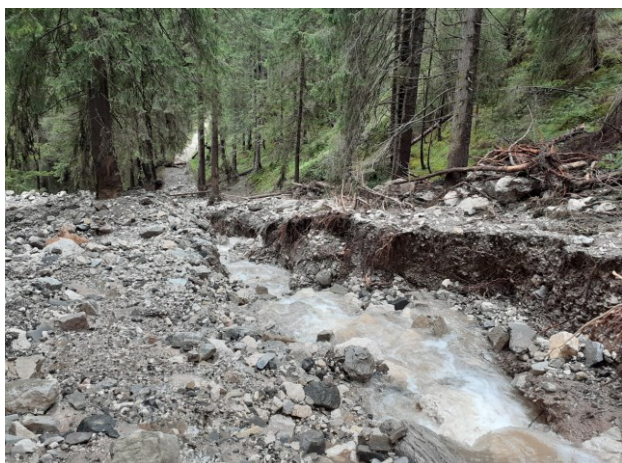
Figura 16. Il collettore principale eroso a monte del conoide (Servizio Bacini Montani, PAT)
