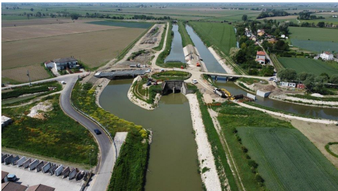
Foto 9 opere in fase di completamento
