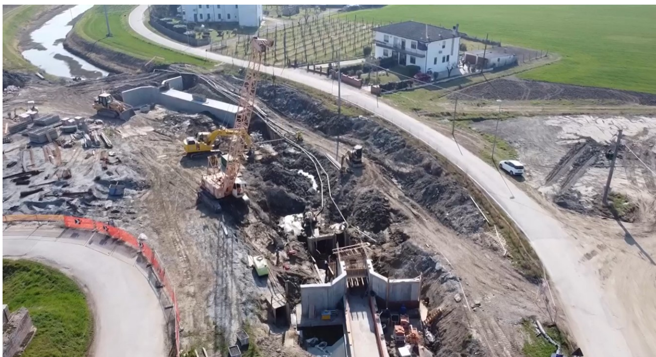
Foto 8 botte irrigatore durnate la fase di costruzione
