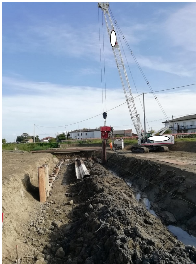
Foto 5 infissione palancole provvisorie
