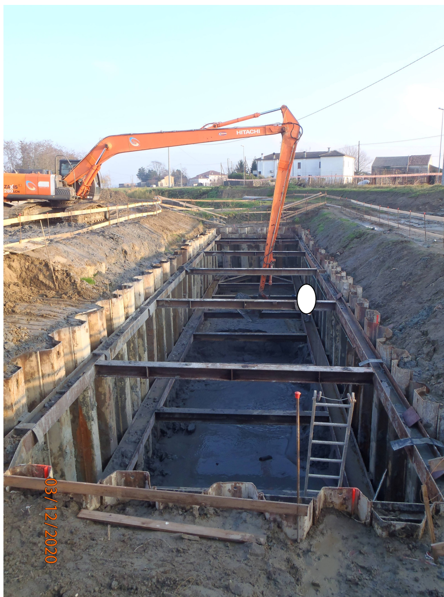
Foto 6 scavo all'interno del palancolato
