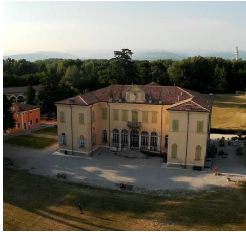
Figura 2. Facciata sud di Villa Buri
