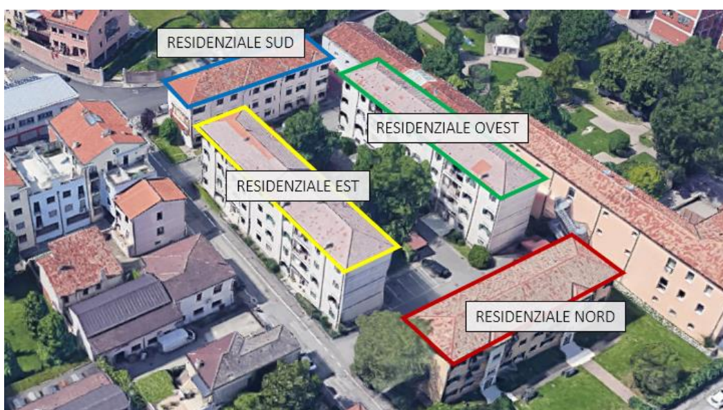
Figura 14: Complesso residenziale "social housing"
