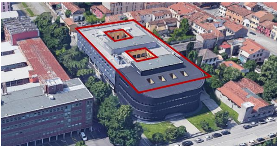
Figura 11: Dipartimento di Geoscienze
