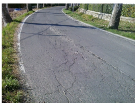
Foto 5 – SP 106 Pilla al km 0+385
