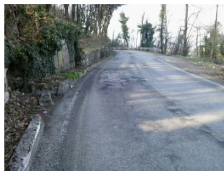
Foto 6 – SP 106 Pilla al km 1+826
