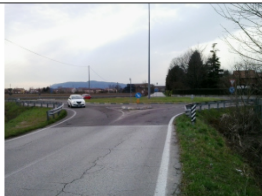
Foto 4 – SP 117 Camisana al km 6+133
