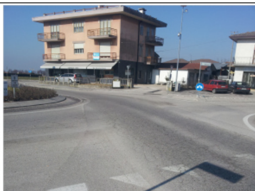
Foto 3 – SP 117 Camisana al km 2+500
