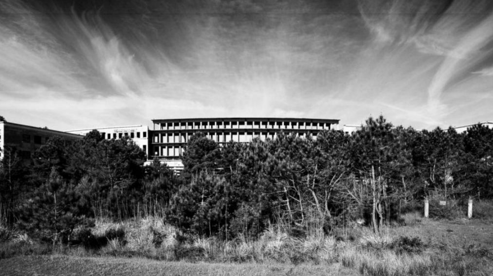
Figura 71 - colonia Varese, Milano Marittima, 2016, prospetto corpo principale struttura fronte mare, foto di Fabio Cubellini
