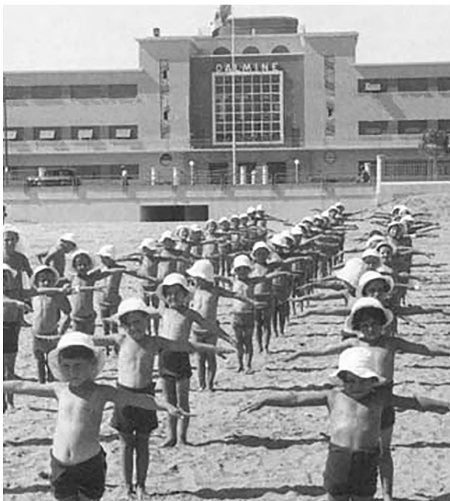
Figura 8 - Colonia Dalmine di Riccione, anni Trenta, sullo sfondo facciata principale con tamponamento in vetrocemento
