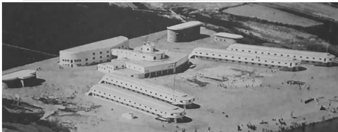
Figura 11 - Colonia marina XXVIII ottobre a Cattolica, anni Trenta, impianto planimetrico a forma di nave, prima categoria
