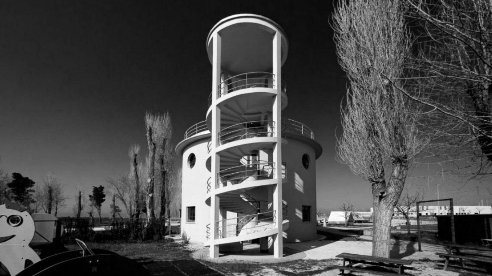
Figura 73 - colonia XXVIII ottobre ("Le Navi"), Cattolica, 2017, edificio con alloggi dei responsabili, foto di Fabio Cubellini
