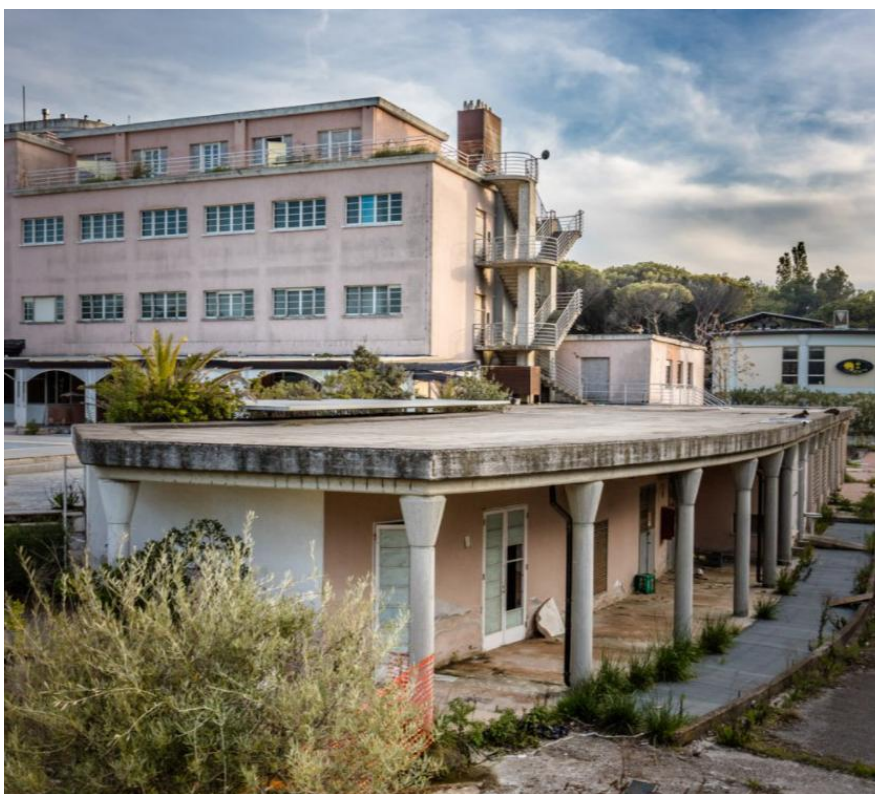
Figura 77 - colonia Dalmine, Rimini, attualmente abbandonata, foto di Danilo Bazzani
