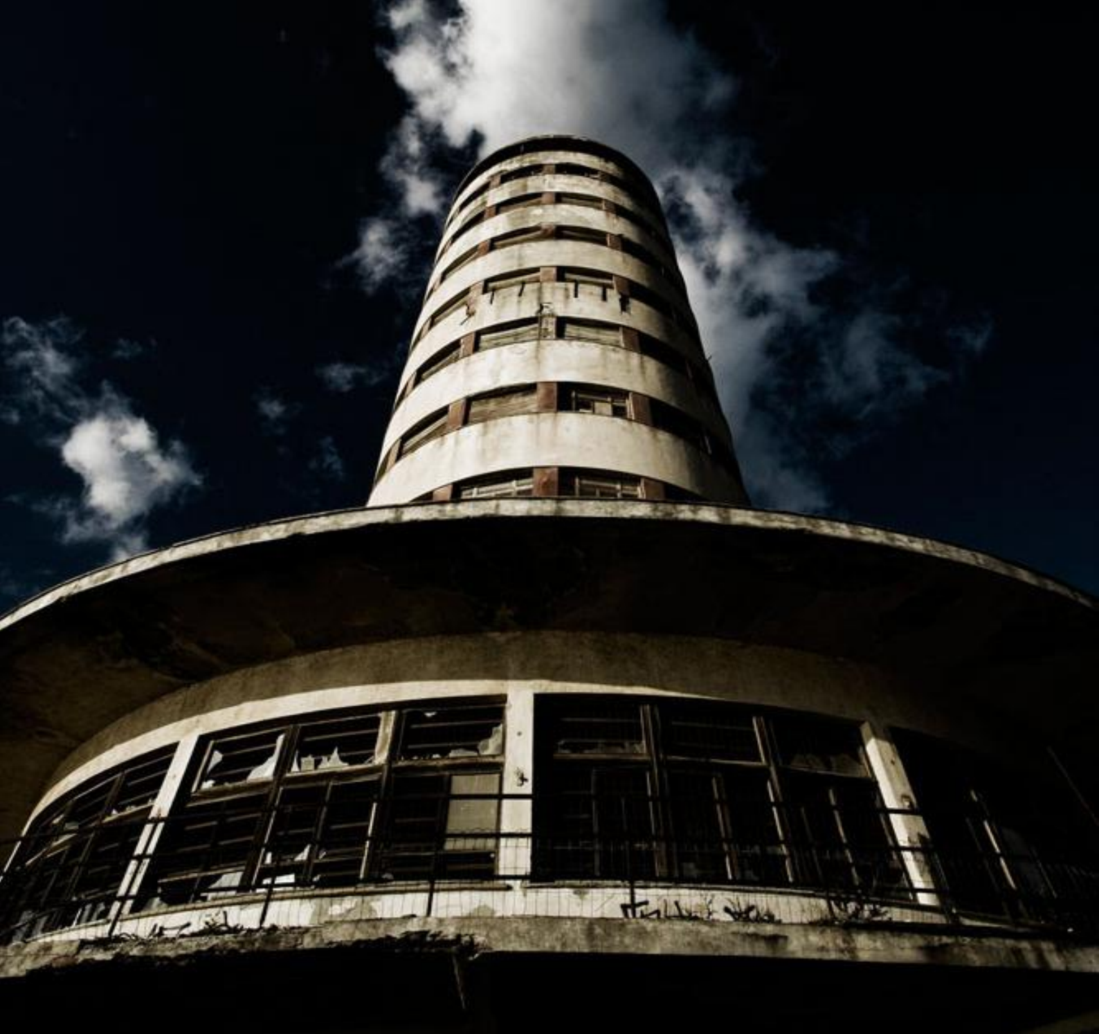
Figura 78 - colonia Fara, Chiavari, foto antecedente il restauro del 2020
