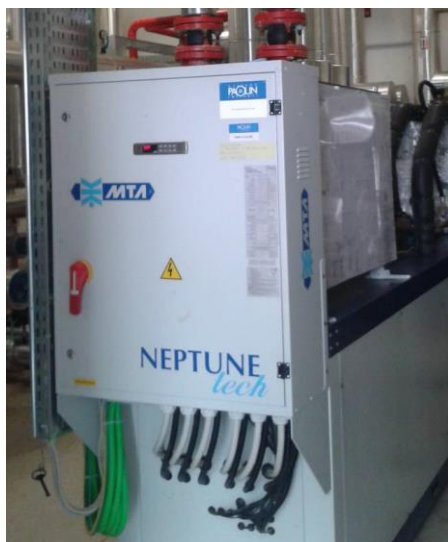
Figura 2.12 : Pompa di calore
