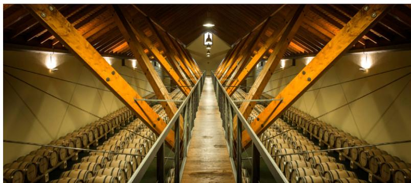
Figura 2.56: vista della passerella sopraelevata sostenuta da un sistema di travi in legno e cavi d'acciaio delle Cantine Chivite ad Arínzano.
