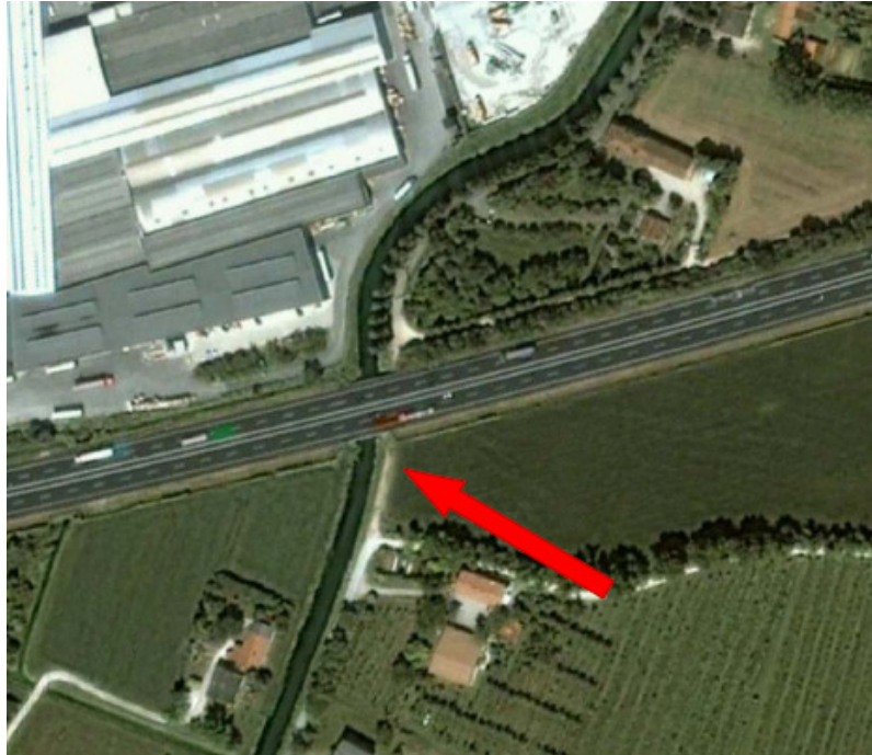
Figura 5-3: Foto aerea del ponte sul fiume Meolo
