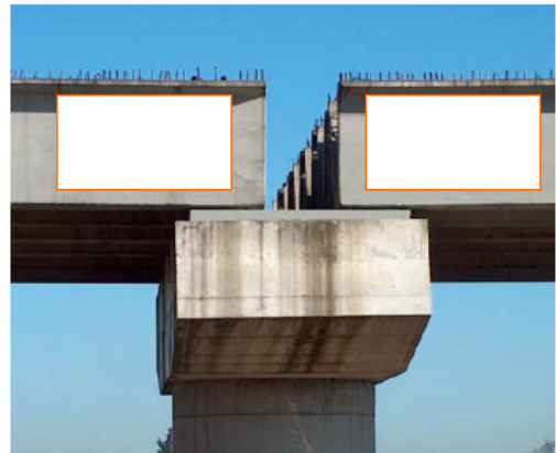
Fase 2: Getto baggiolo con appoggi inglobati e zona infissione connettori cls-cls evidenziata
