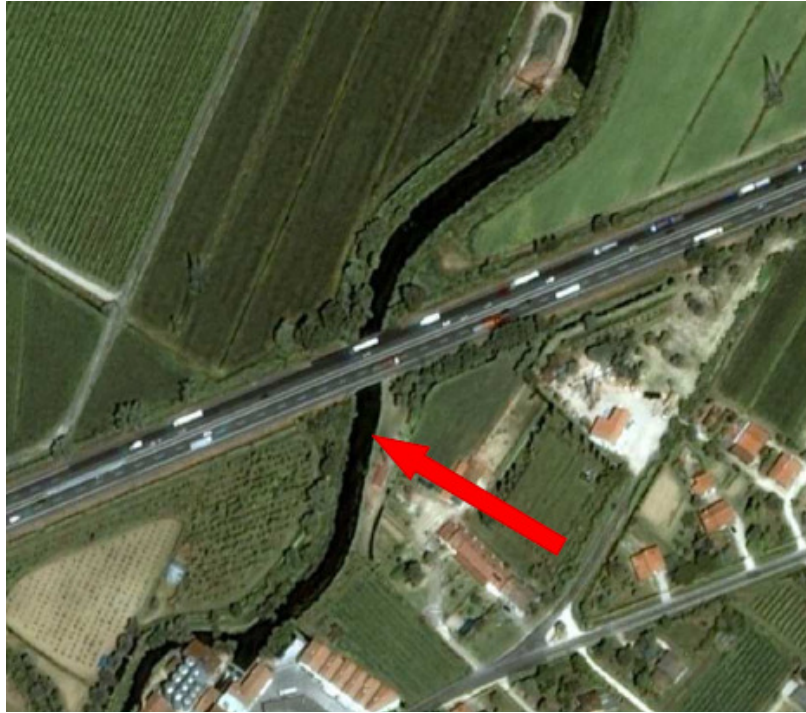
Figura 5-7: Foto aerea del ponte sul fiume Musestre
