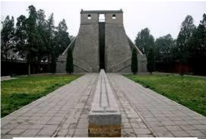
Figura 2 Torre di Dengfeng, nella provincia di Henan. Conosciuta anche come Osservatorio di Gaocheng, venne costruito per ordine dell'imperatore Kublai Khan. Si notano la scala graduata e la corda tesa alla sommità della struttura.
